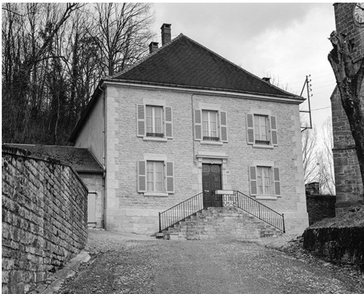
Façade antérieure, vue de face.
