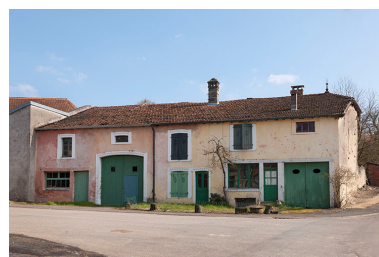
Maisons, rue de la Vigne. Phot. Jérôme Mongreville IVR43_20167000505NUC4A
