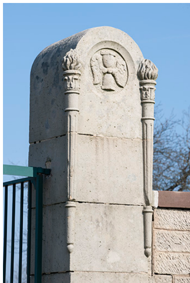
Détail d'un des piliers du portail.
