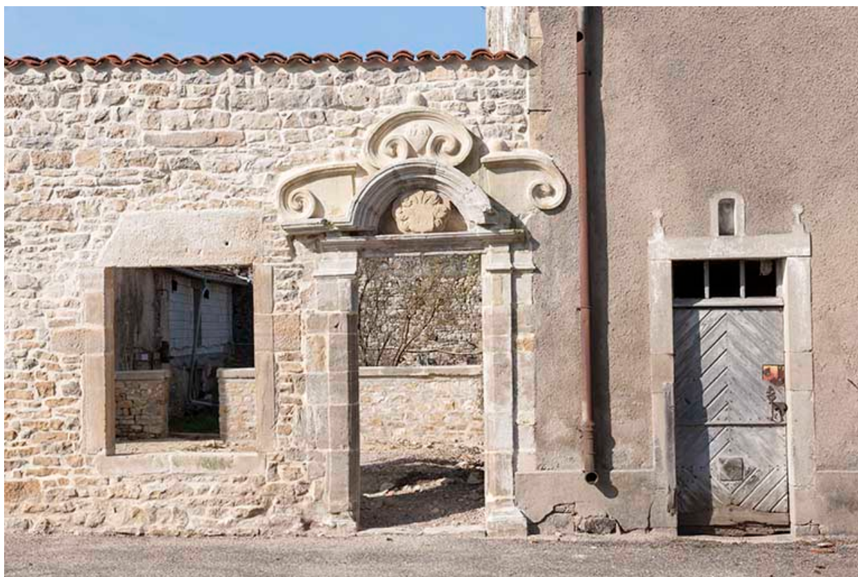
Porte reconstruite avec pierres de remploi.
