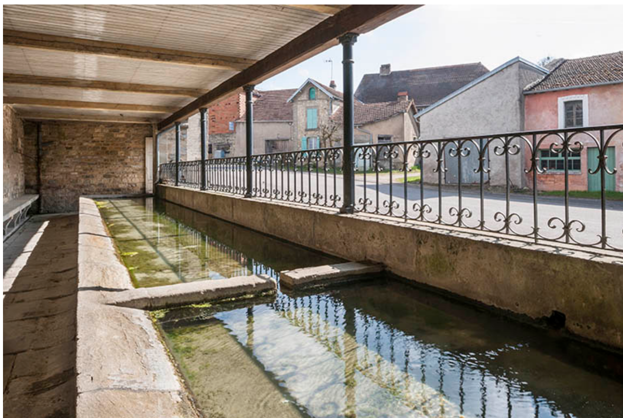
Lavoir, rue de la Vigne.
