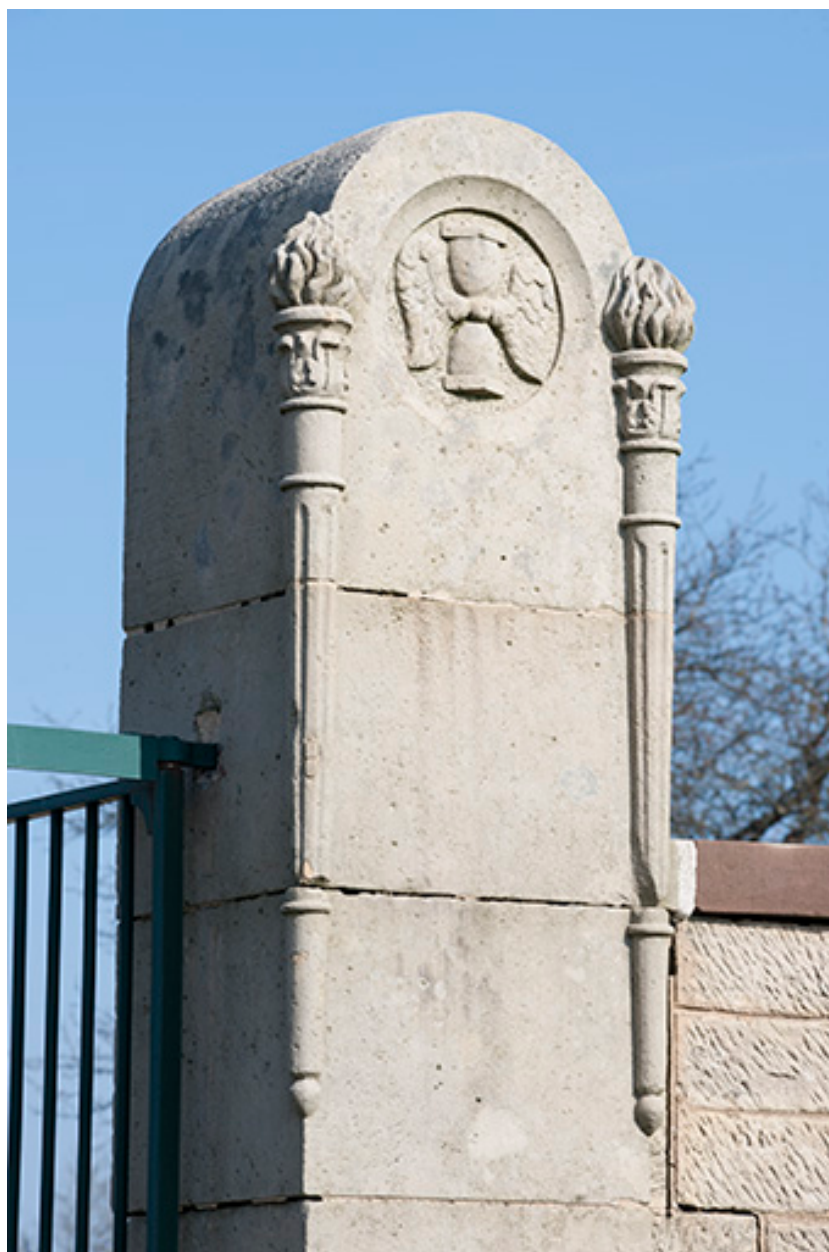
Détail d'un des piliers du portail.
