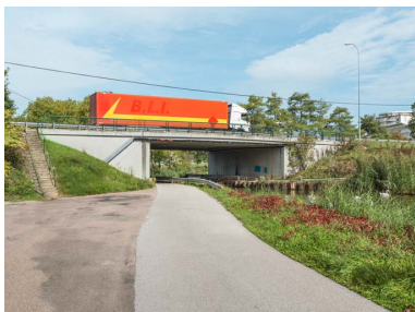
Vue d'ensemble du pont.
