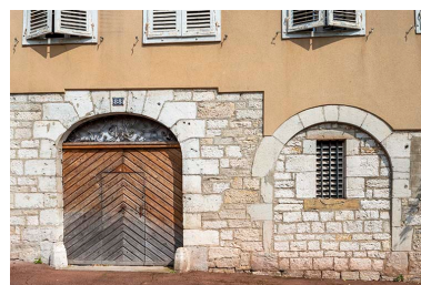
Ouvrures sud de la façade antérieure. Phot. Jérôme Mongreville IVR43_20233900716NUC4A
