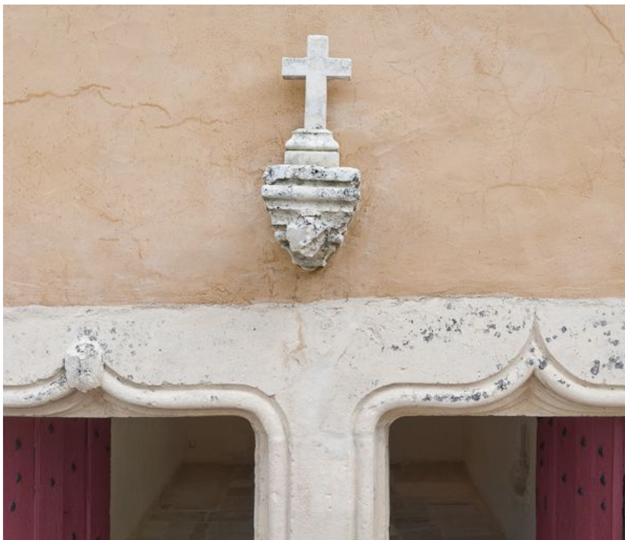
Détail des portes d'entrée en accolade.
