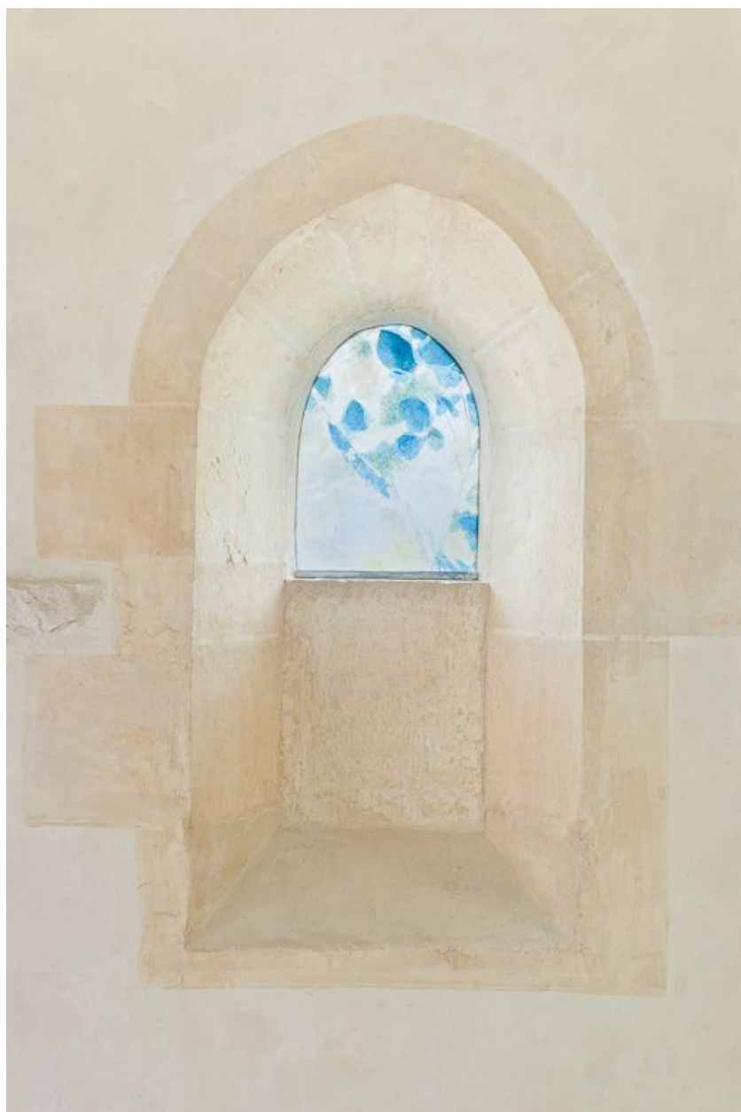
Détail de la baie et de son vitrail, mur gauche.
