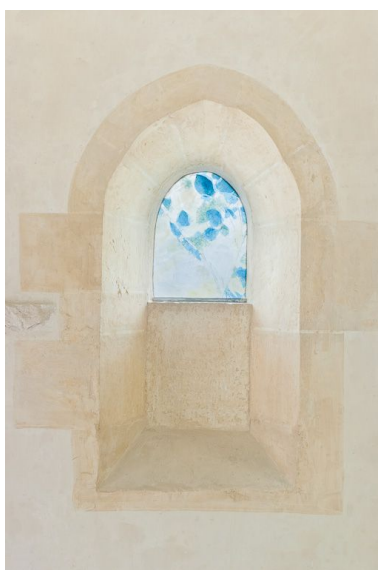
Détail de la baie et de son vitrail, mur gauche. Phot. Pierre-Marie Barbe-Richaud IVR26_20122101481NUC2A
