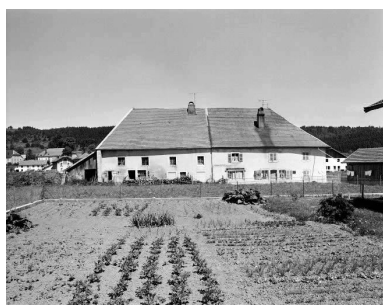
Façade postérieure. Phot. Yves Sancey IVR43_19812500185X
