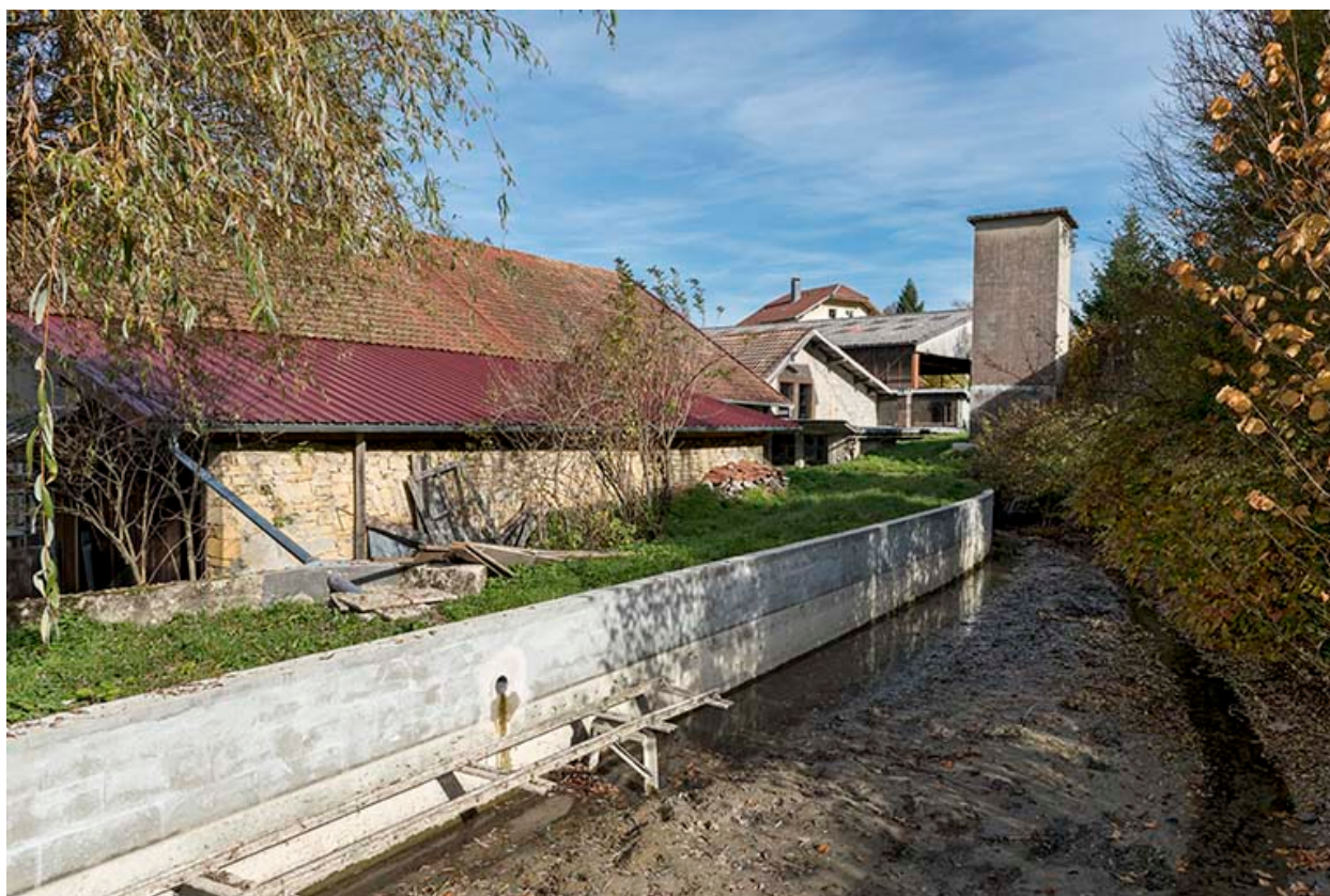
Bâtiment ancien : façade postérieure et canal d'amenée.
