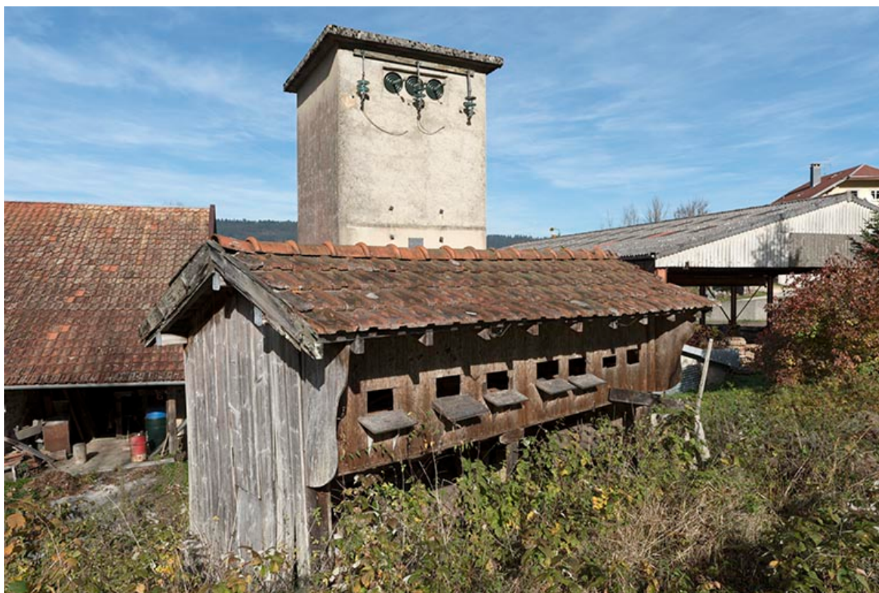
Rûcher et transformateur.
