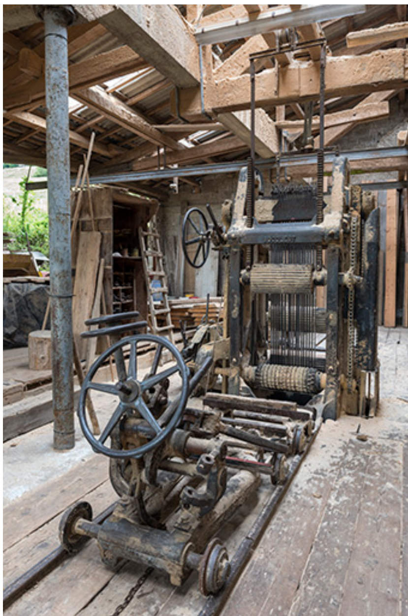
Atelier de fabrication : châssis de scie Socolest.
