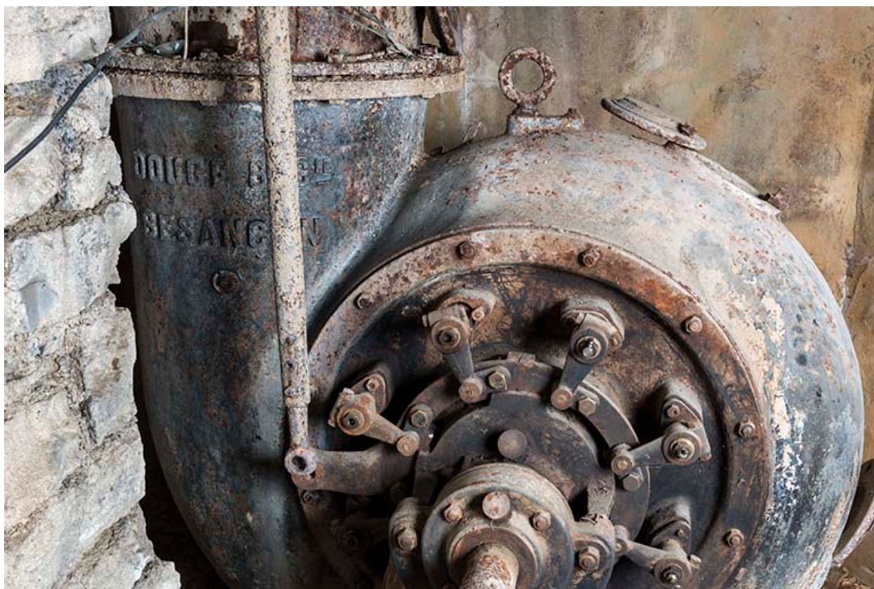
Atelier de fabrication, sciurier : turbine Douge.
