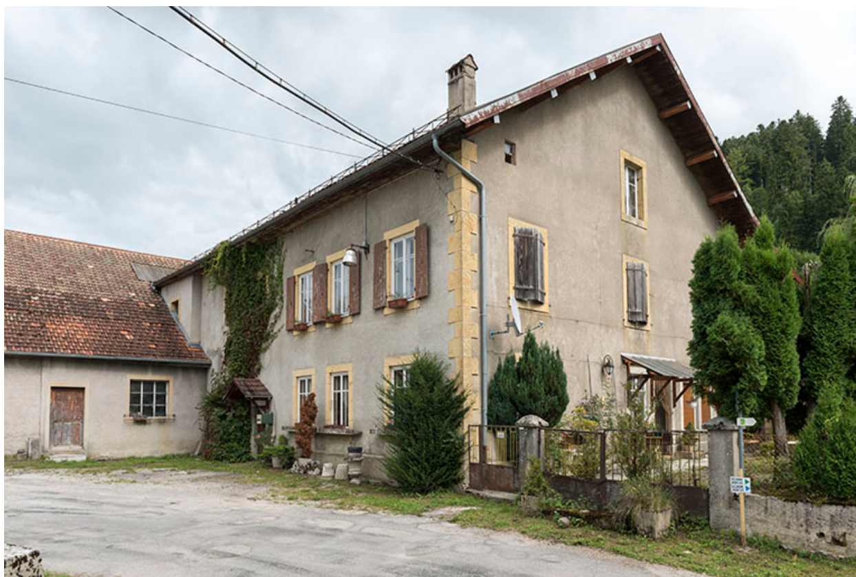
Bâtiment ancien : façades antérieure et latérale droite.
