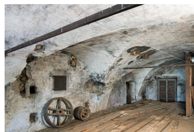
Bâtiment ancien, partie centrale : voûte d'arêtes au 2e étage. Phot. Sonia Dourlot IVR43_20172501664NUC4A
