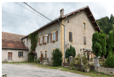
Bâtiment ancien : façades antérieure et latérale droite. Phot. Sonia Dourlot IVR43_20172501661NUC4A
