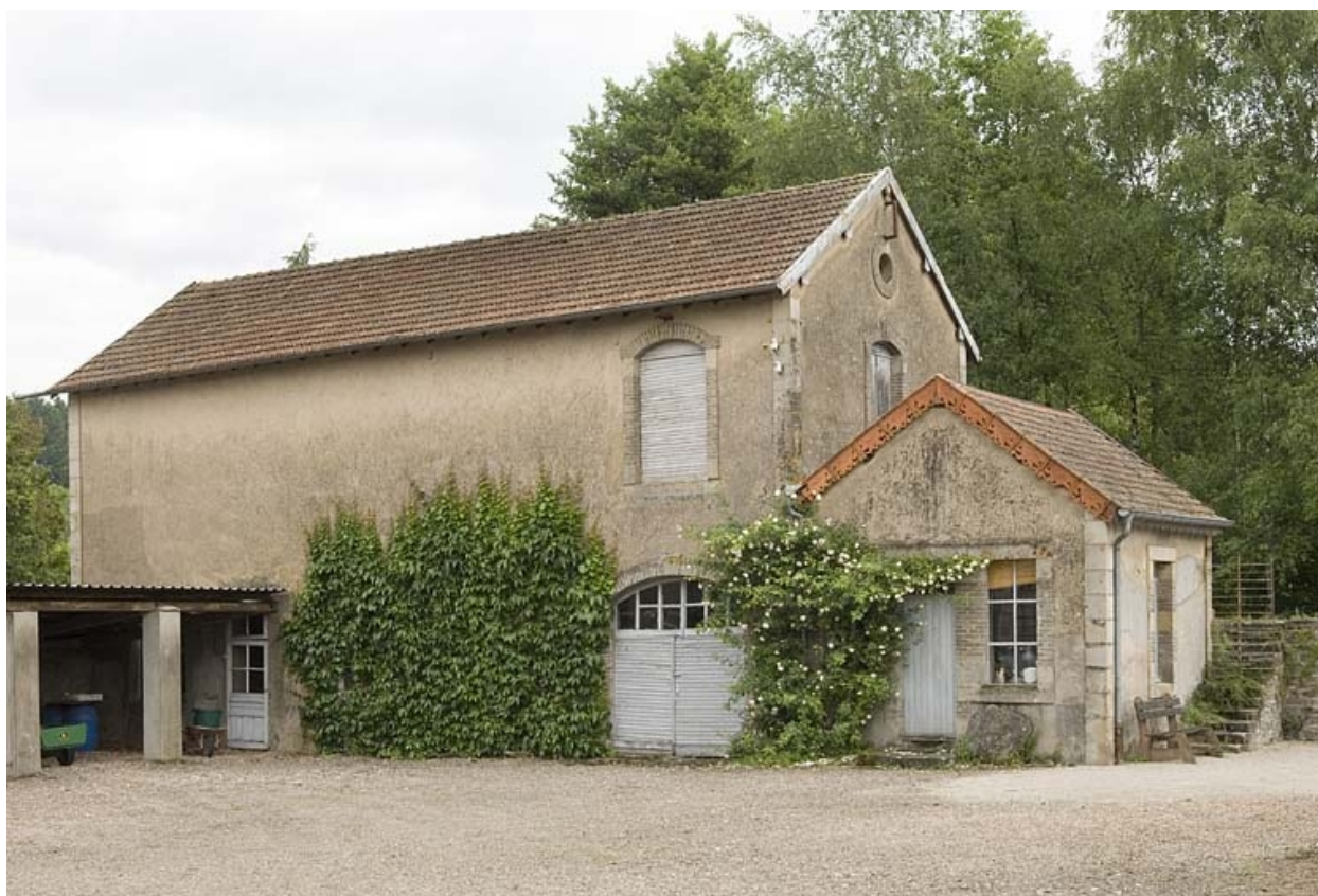
Entrepôt industriel et bureau.
