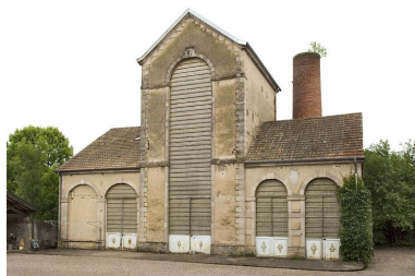
Bâtiment de rectification vu de face. Phot. Jérôme Mongreville IVR43_20097000330NUC2A
