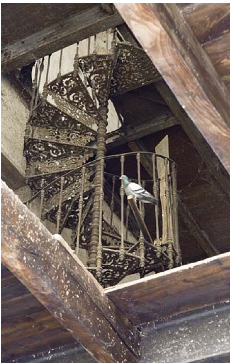
Bâtiment de rectification. Escalier intérieur en fonte.
