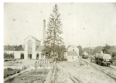
Vue d'ensemble depuis le sud Phot. Jérôme Mongreville, Autr. A. Le Blanc IVR43_20097000340NUC2A
