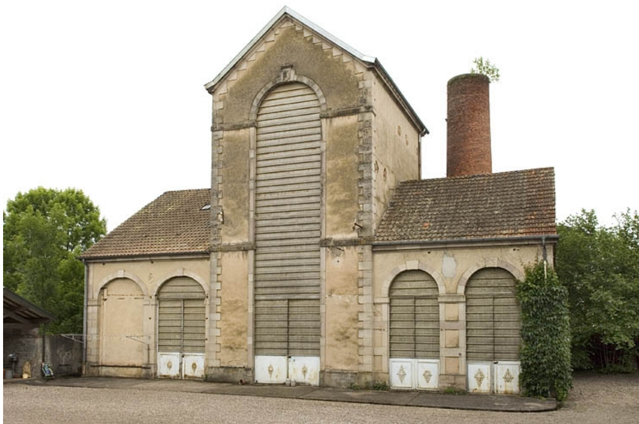
Bâtiment de rectification vu de face.
