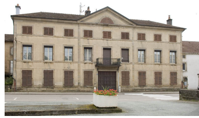
Vue de face du relais de poste. Phot. Jérôme Mongreville IVR43_20097000344NUC2A
