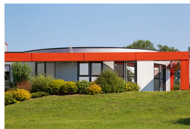
Façade postérieure : bureaux. Phot. Yves Sancey IVR43_20132501360NUC2A
