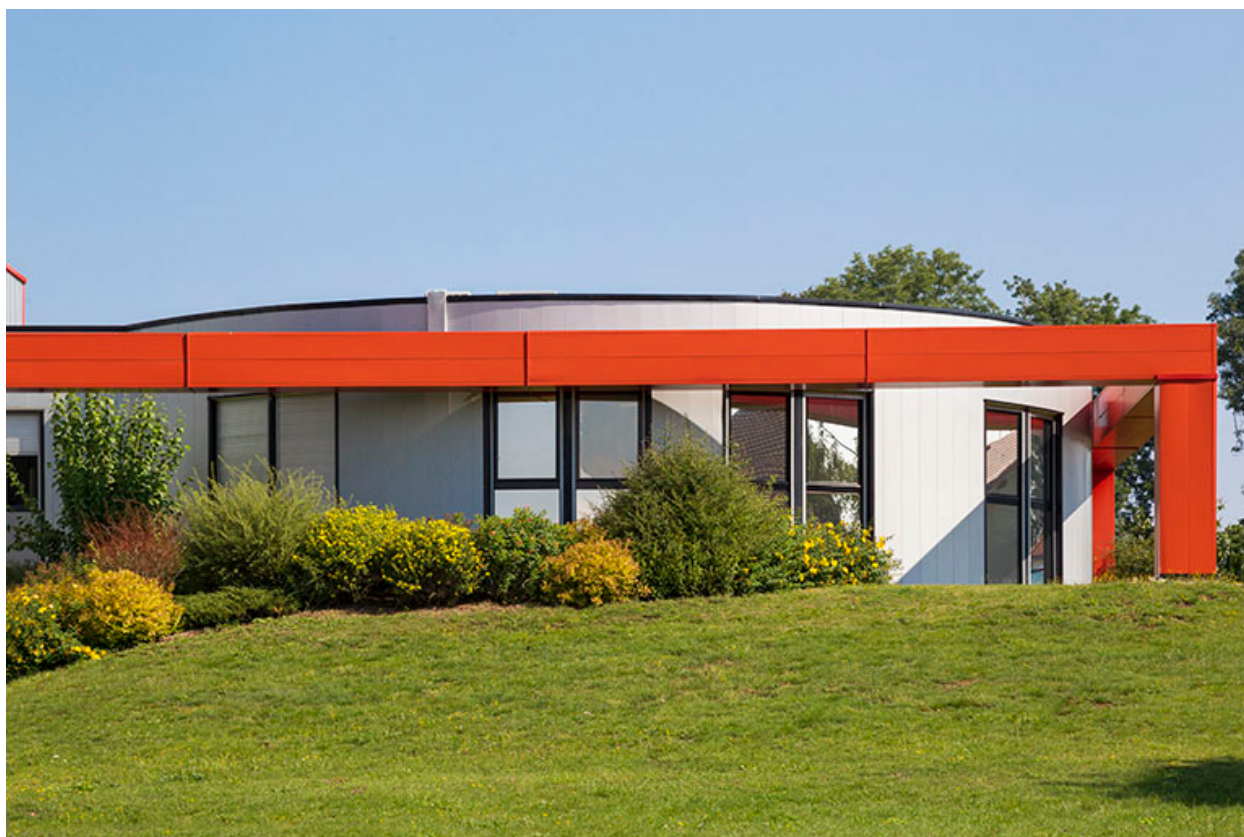
Façade postérieure : bureaux.
