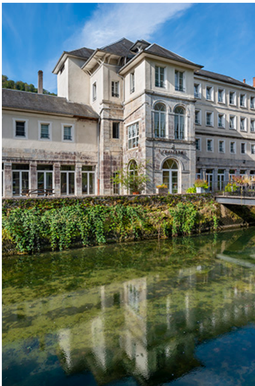
Façade principale, vue de trois quarts, détail.
