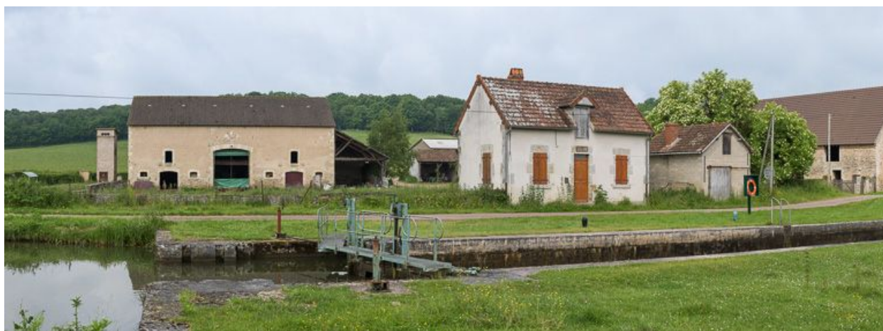
Vue d'amont du site d'écluse.
