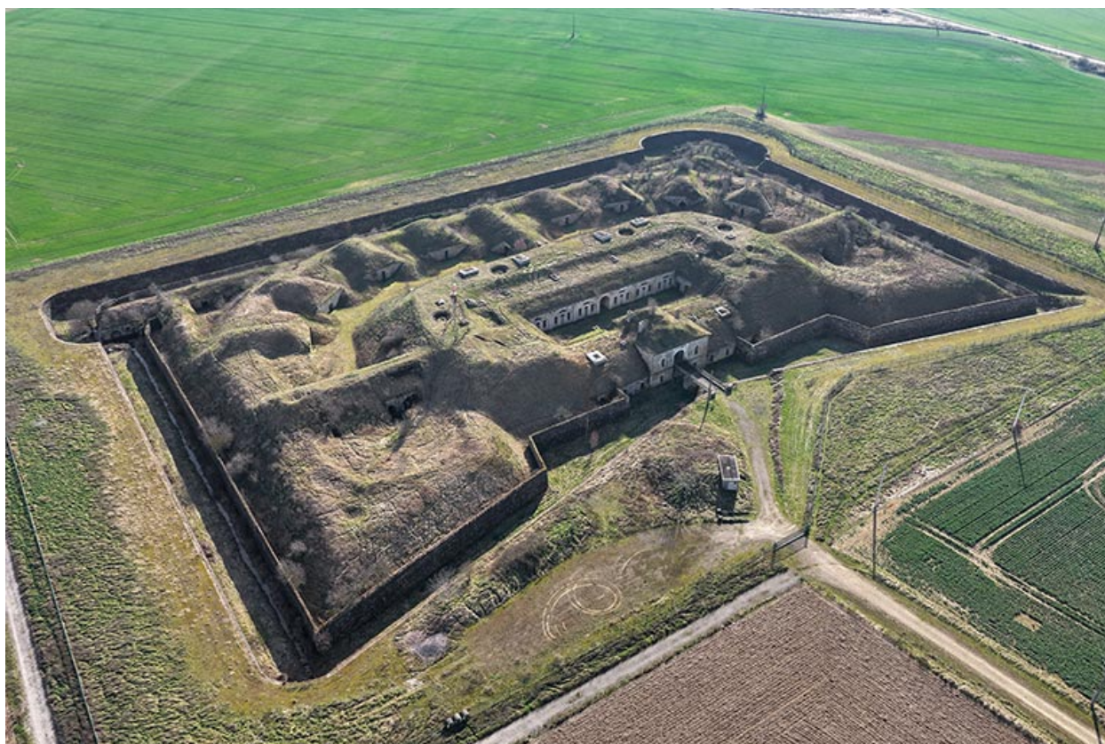
Fort de Beauregard. (vue aérienne).
