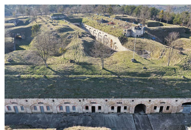
Fort de la Motte-Giron : la caserne des officiers, la cour flanquée de son casernement et le cavalier. (vue aérienne). Phot. Nicolas Douriaux IVR26_20262100398NUC4A
