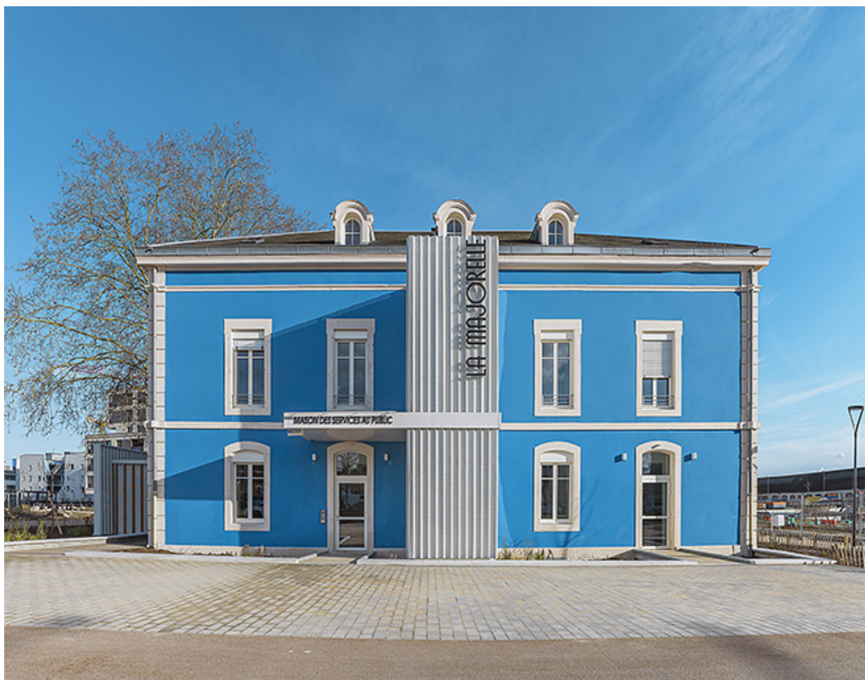
Site de l'ancien arsenal de Dijon : maison du "colonel."
