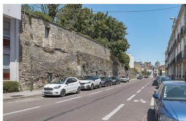
Le rempart subsistant, rue de Tivoli. Phot. Thierry Kuntz IVR26_20252100096NUC4A
