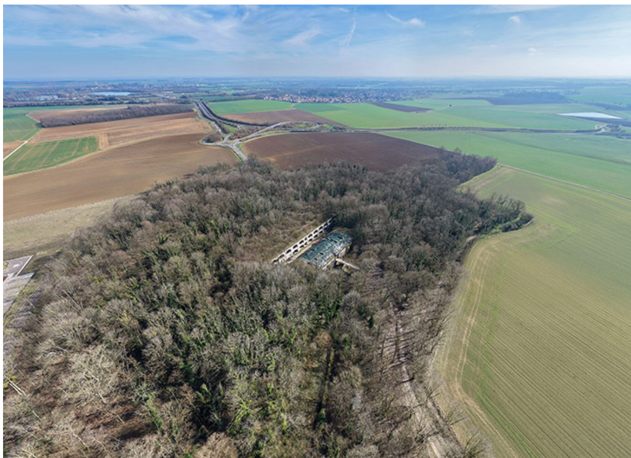
Fort de Varois. (vue aérienne).
