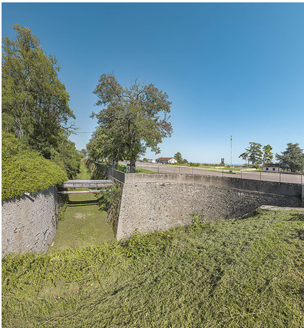
Fort d'Hauteville : fossé du front de gorge.
