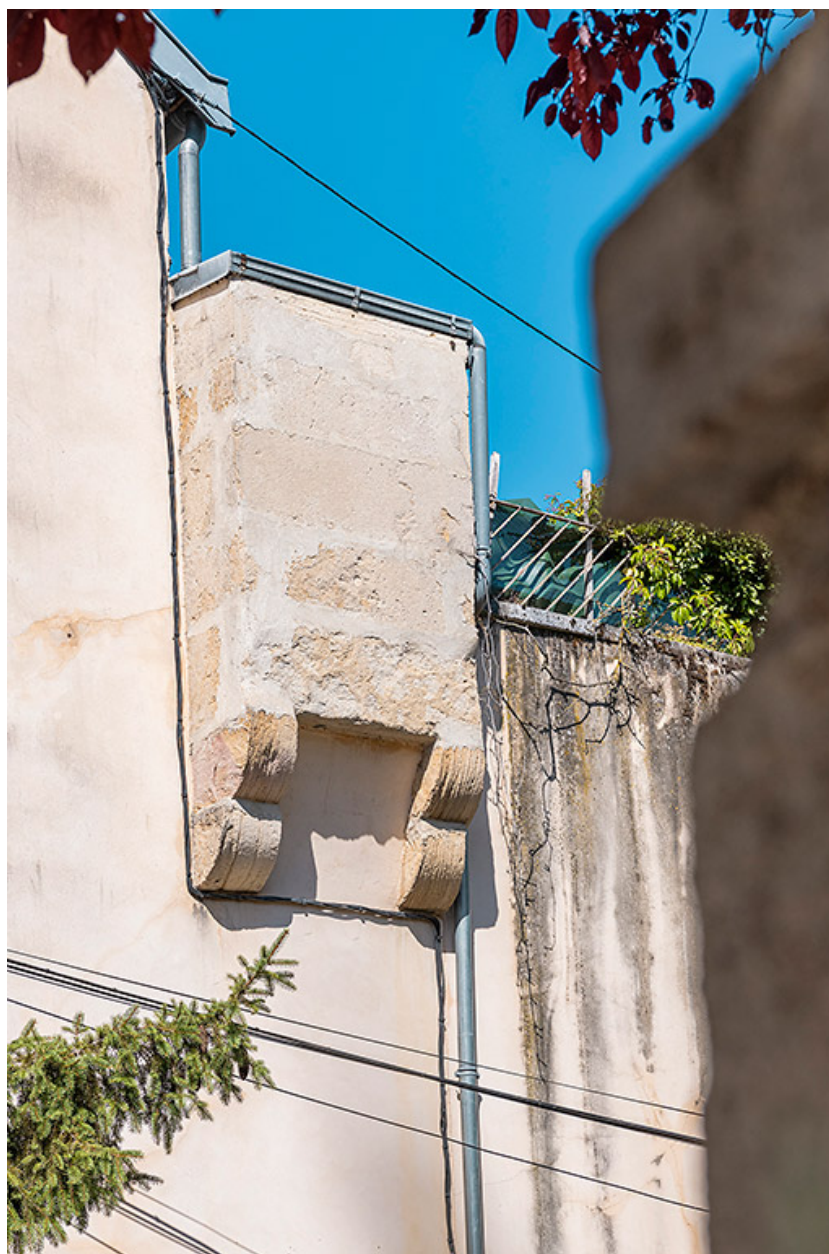
Vestige d'un ouvrage fortifié médiéval, rue Berlier.
