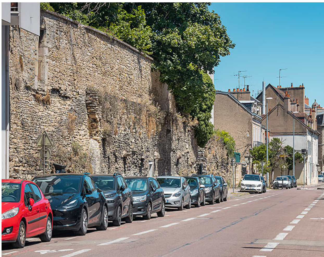
Le rempart (vue centrée), rue de Tivoli.
