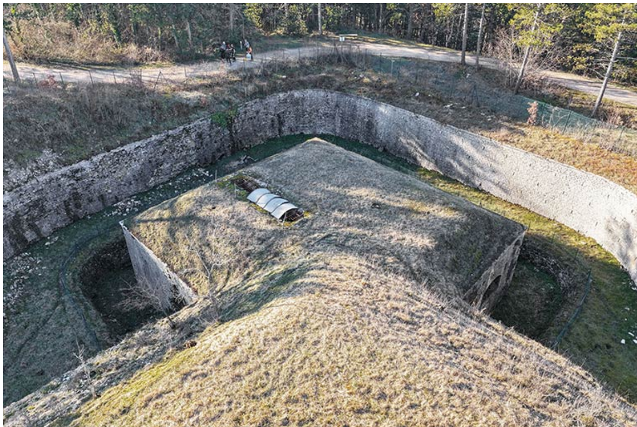
Fort de la Motte-Giron : double caponnière. (vue aérienne).
