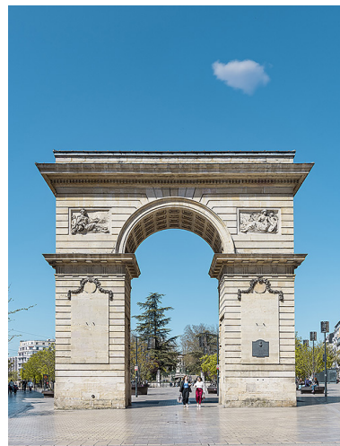
Porte Guillaume construite à la fin du 18e siècle à l'emplacement d'une ancienne porte médiévale intégrée à l'enceinte urbaine. Phot. Thierry Kuntz IVR26_20252100080NUC4A
