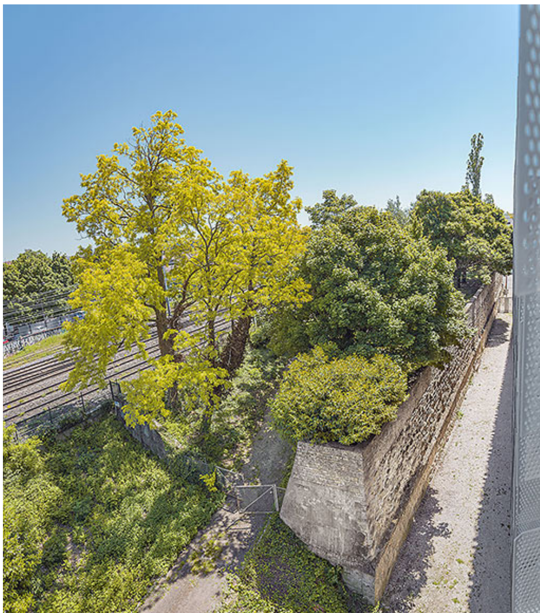
Le bastion de Guise et son talus supportant les voies ferrées.
