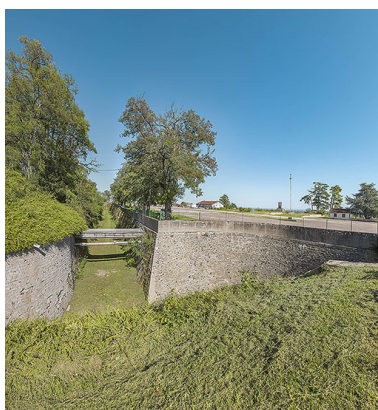
Fort d'Hauteville : fossé du front de gorge. Phot. Thierry Kuntz IVR26_20252100245NUC4A
