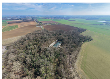
Fort de Varois. (vue aérienne). Phot. Nicolas Douriaux IVR26_20262100363NUC4A
