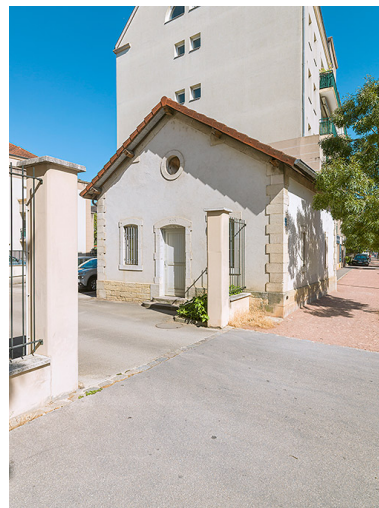
Corps de garde du magasin à poudre, rue d'Auxonne. Phot. Thierry Kuntz IVR26_20252100383NUC4A
