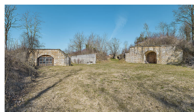
Batterie annexe du fort d'Asnières, située sur la commune de Norgues. Phot. Thierry Kuntz IVR26_20252100065NUC4A
