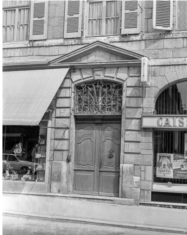
Porte d'entrée. Phot. Yves Sancey IVR43_19802500217X
