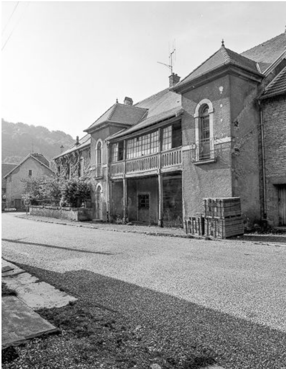
Façade latérale droite.
