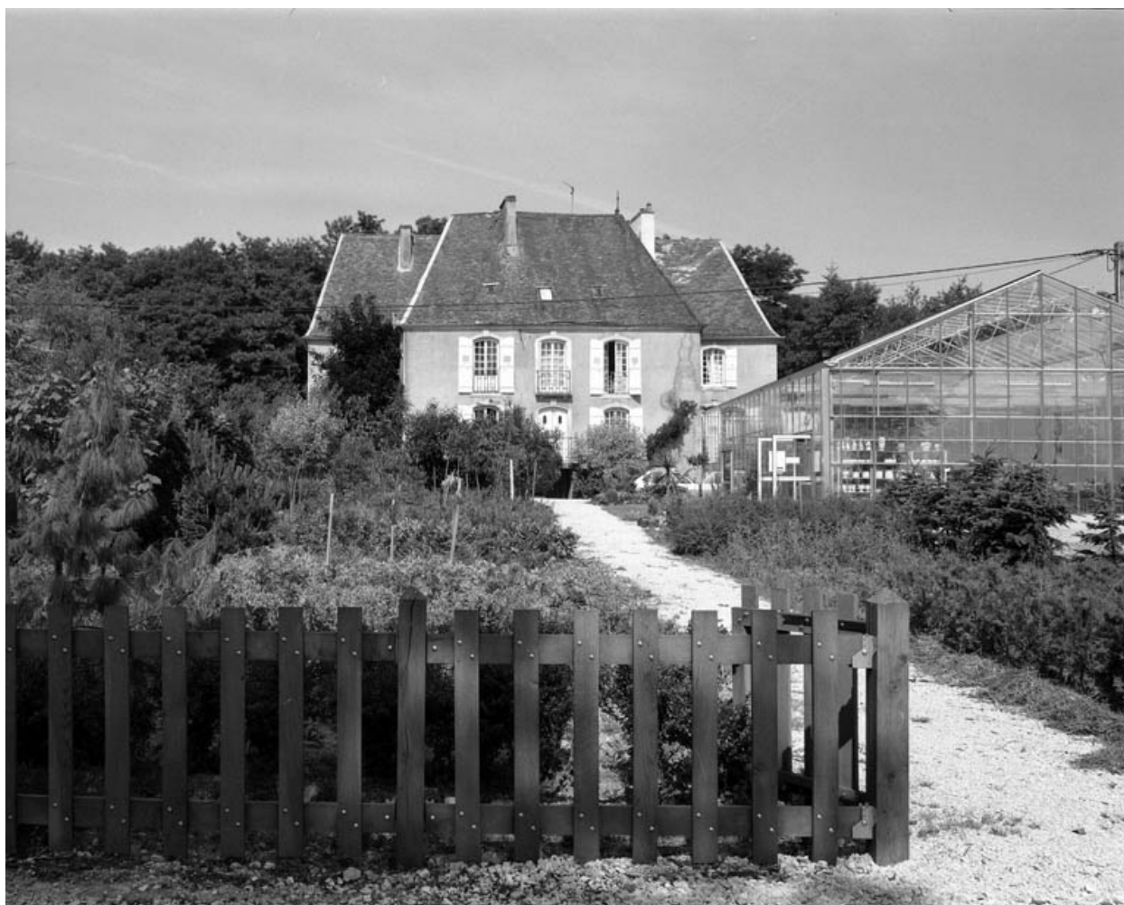
Vue d'ensemble de face depuis la rue.
