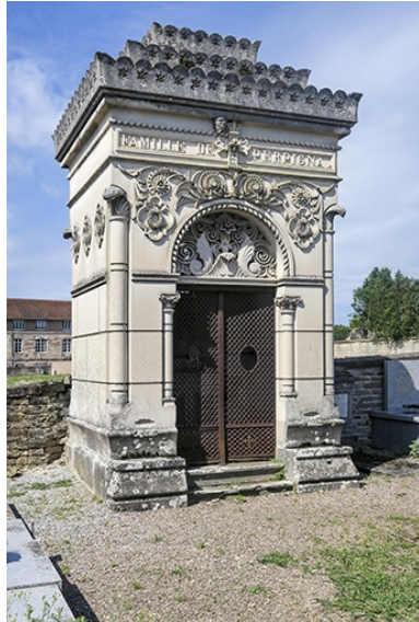
Vue d'ensemble. Phot. Fabien Dufoulon IVR43_20217000434NUC2A
