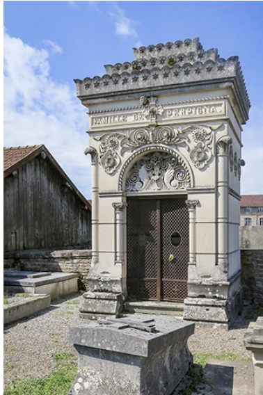
Vue d'ensemble. Phot. Fabien Dufoulon IVR43_20217000433NUC2A
