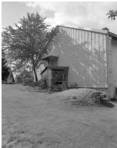
Face gauche recouverte d'un essentage de zinc. Phot. Jérôme Mongreville IVR43_19943900716X
