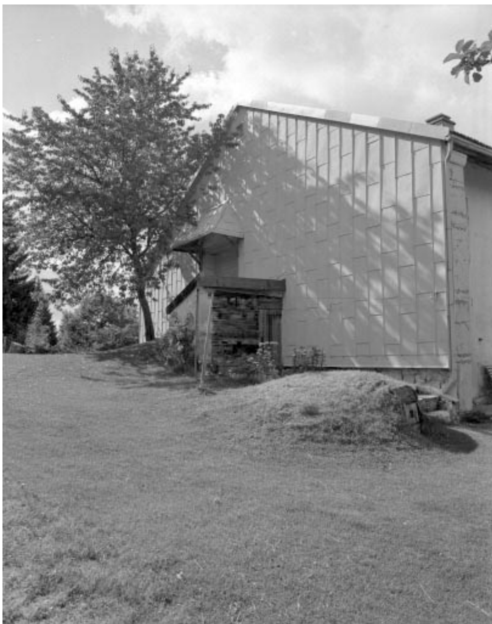
Face gauche recouverte d'un essentage de zinc.
