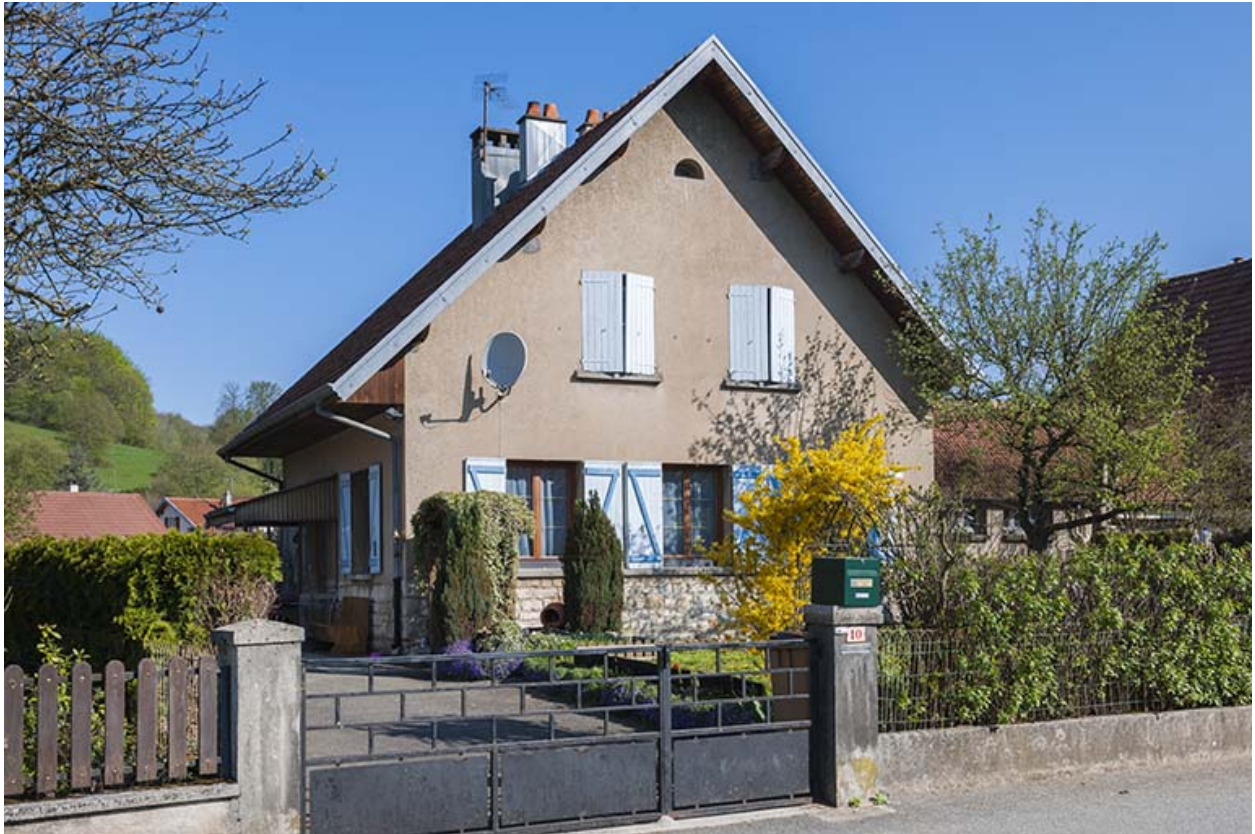
Façade antérieure d'une maison (rue des Ecoles).
