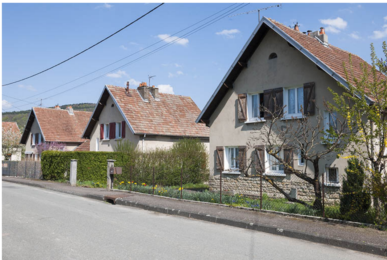
Alignement de façades rue de Champagne.
