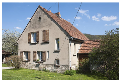
Façade antérieure d'une maison. Phot. Jérôme Mongreville IVR43_20132500212NUC4A
