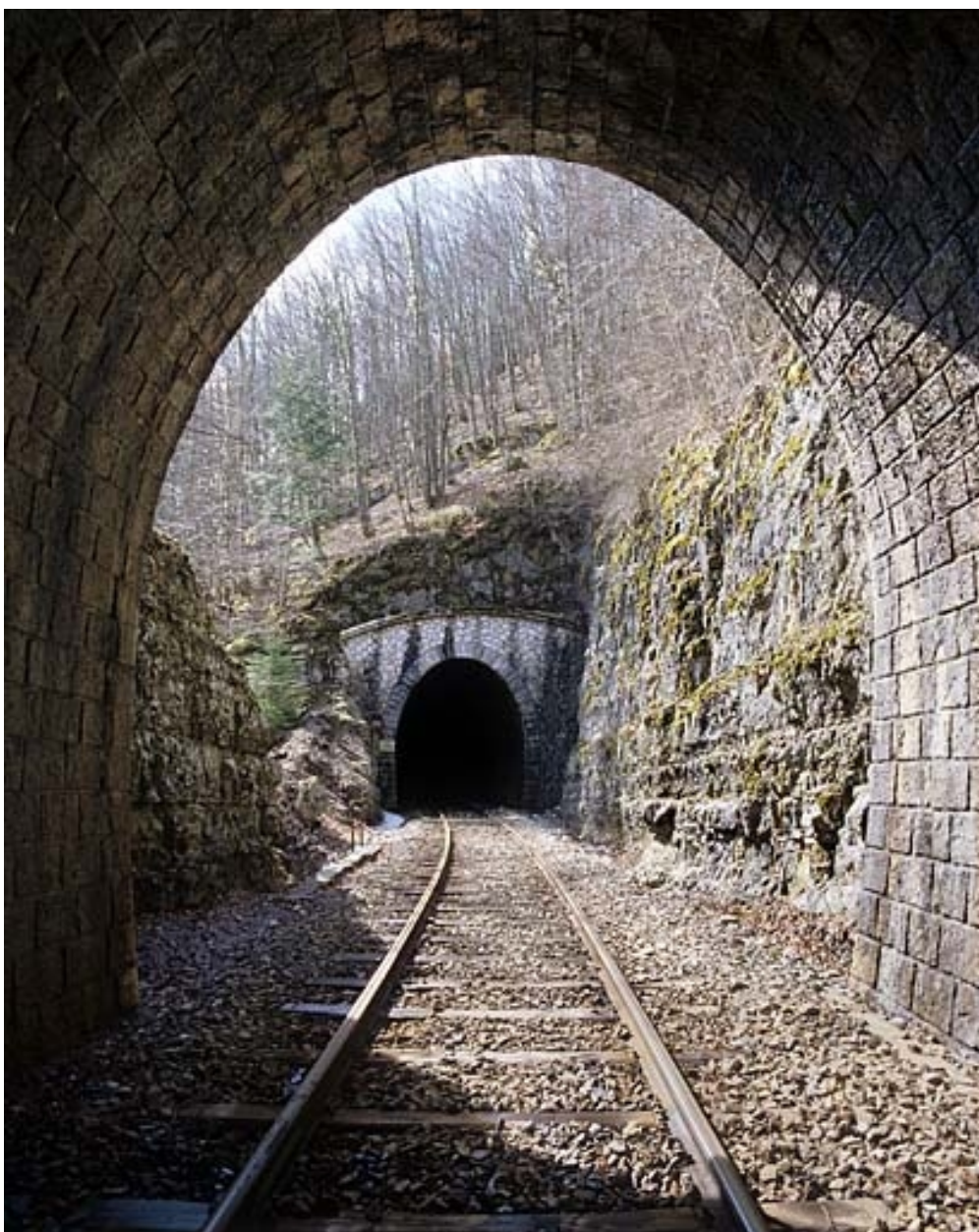
Tunnel du Grépillon.
