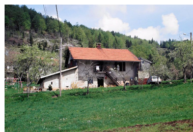
Fromagerie, actuellement maison, située chemin de Cuisiniers. Phot. Yves Sancey IVR43_19993900217ZA
