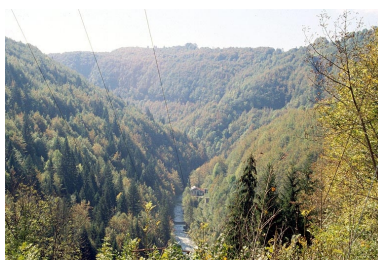
Centrale hydroélectrique de la S.A. d'Electricité de Morez. Phot. Laurent Poupard IVR43_19903900527ZA
