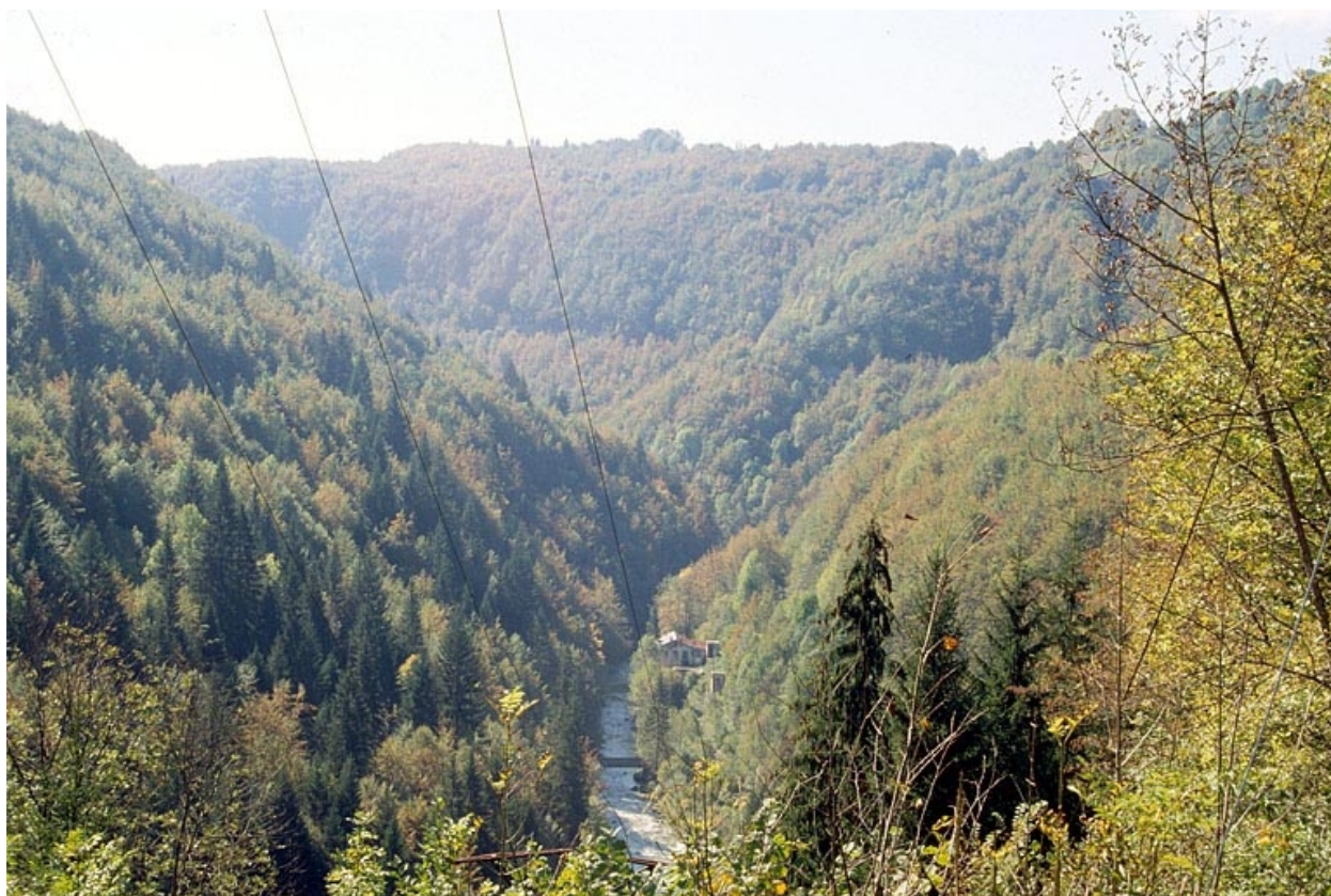
Centrale hydroélectrique de la S.A. d'Electricité de Morez.
