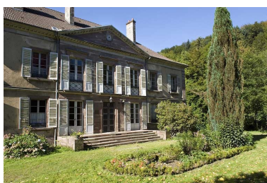
Façade nord vue de trois quarts. Phot. Jérôme Mongreville
