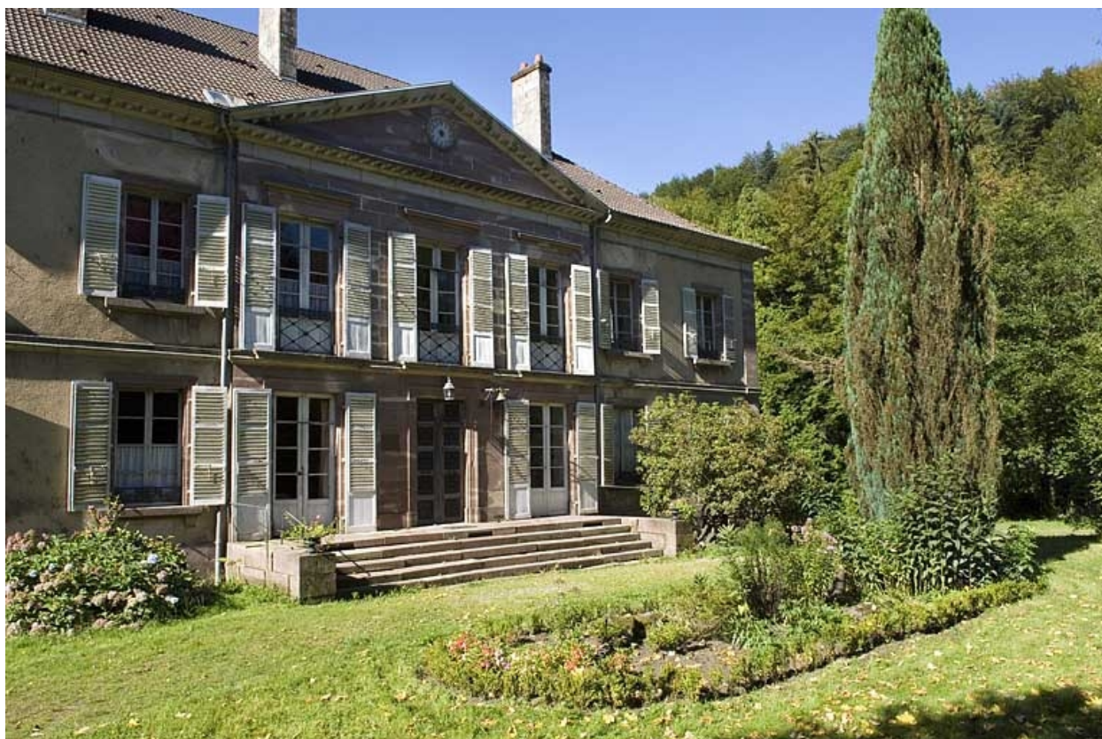
Façade nord vue de trois quarts.
