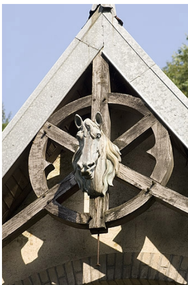
Pignon central des écuries. Décor sculpté. Phot. Jérôme Mongreville IVR43_20067000738NUCA
