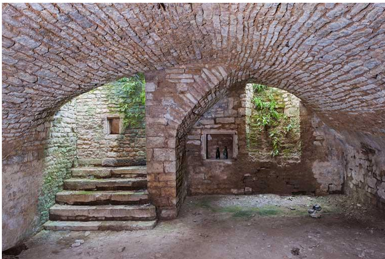
Vue générale de la cave
