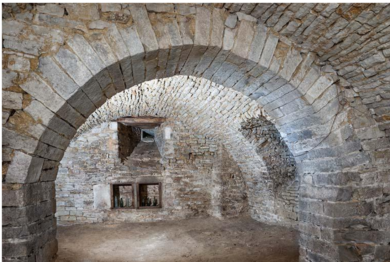
Vue générale de la cave
