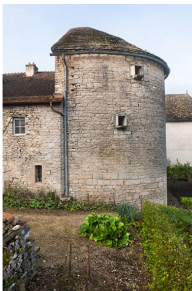
La tour de l'enceinte située au nord Phot. Jérôme Mongreville IVR43_20137000191NUCA
