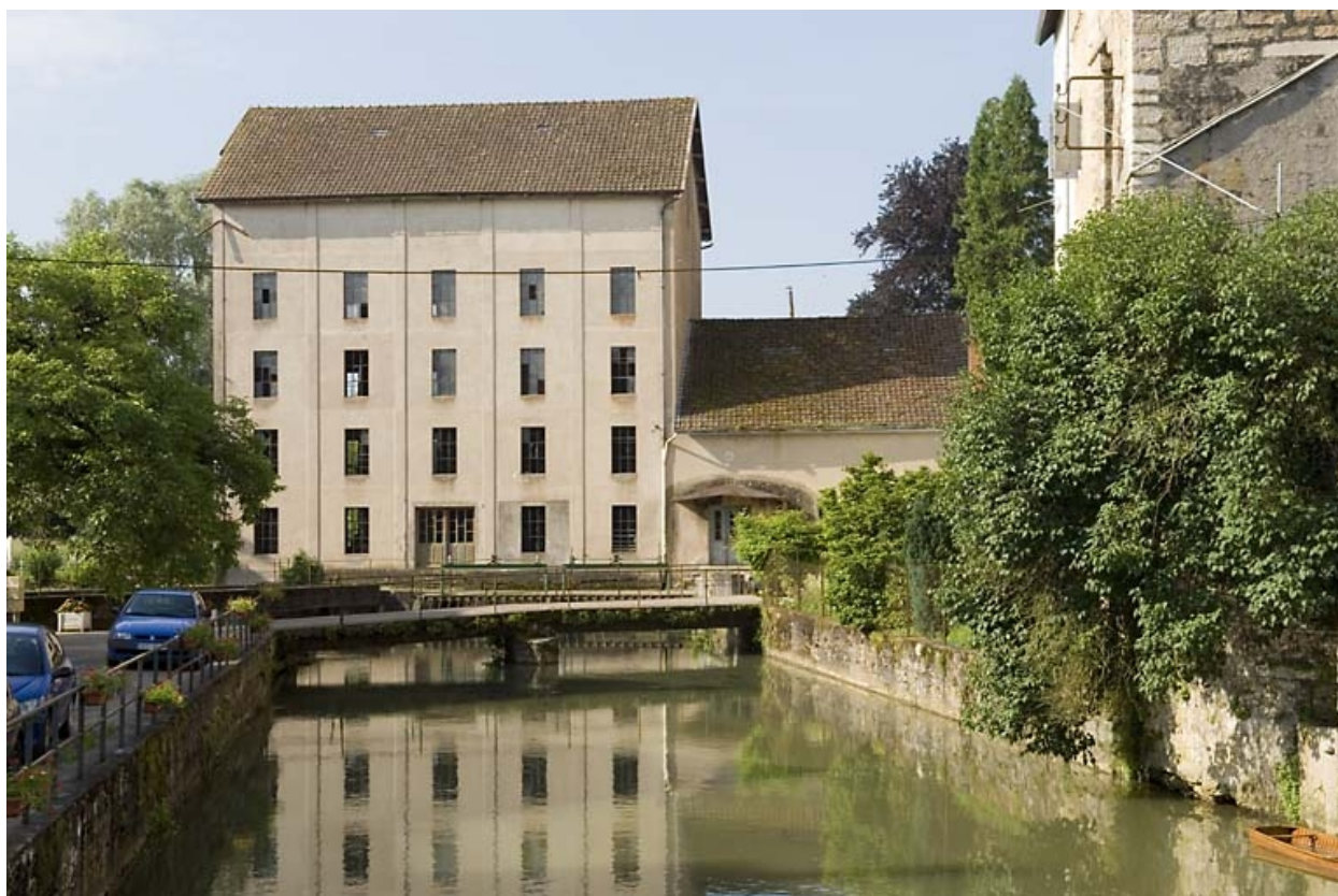
Vue depuis l'amont du bief.
