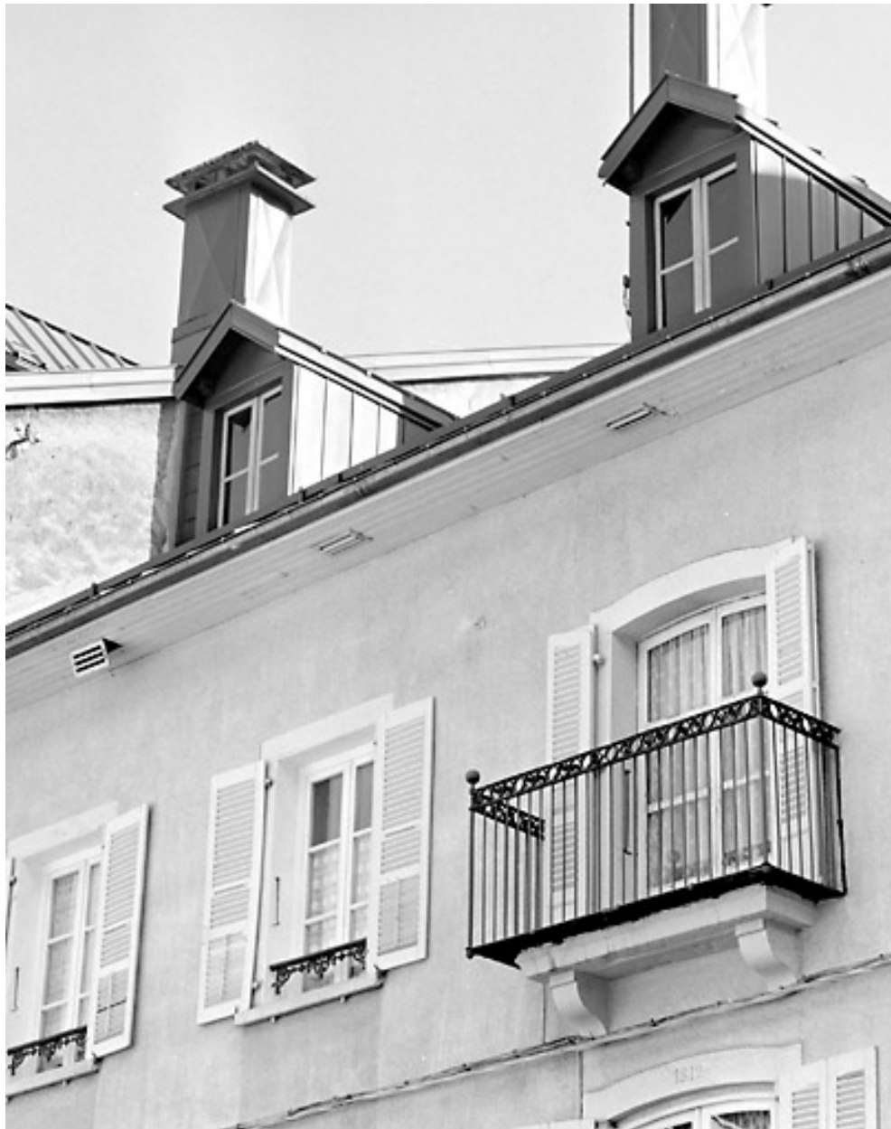
Fenêtres et balcon du deuxième étage.
