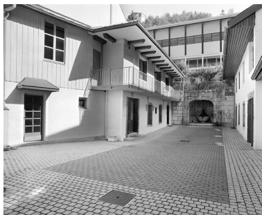
Ancienne dépendance nord. Phot. Yves Sancey IVR43_20033900753X
