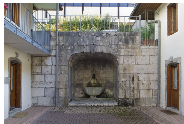
Mur de soutènement, niche et fontaine. Phot. Yves Sancey IVR43_20103900448NUC2A
