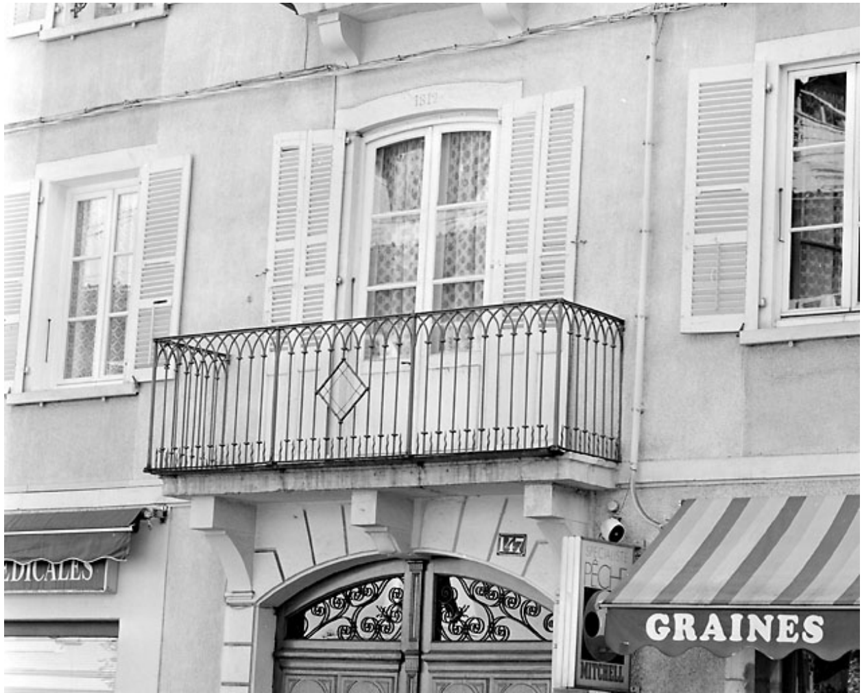
Porte-fenêtre et balcon du premier étage.
