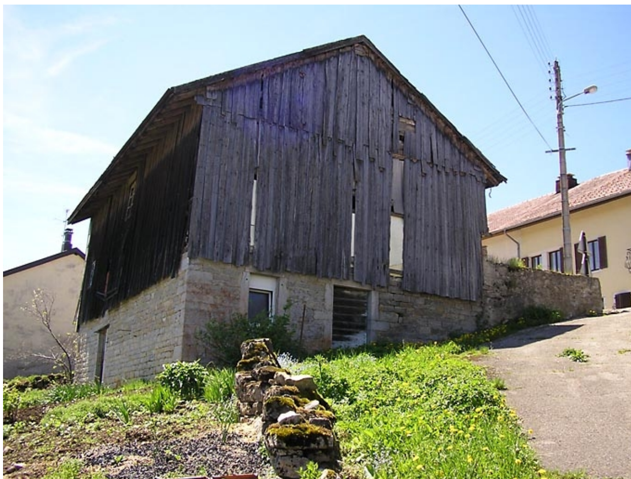
Pignon sud vu de trois quarts.
