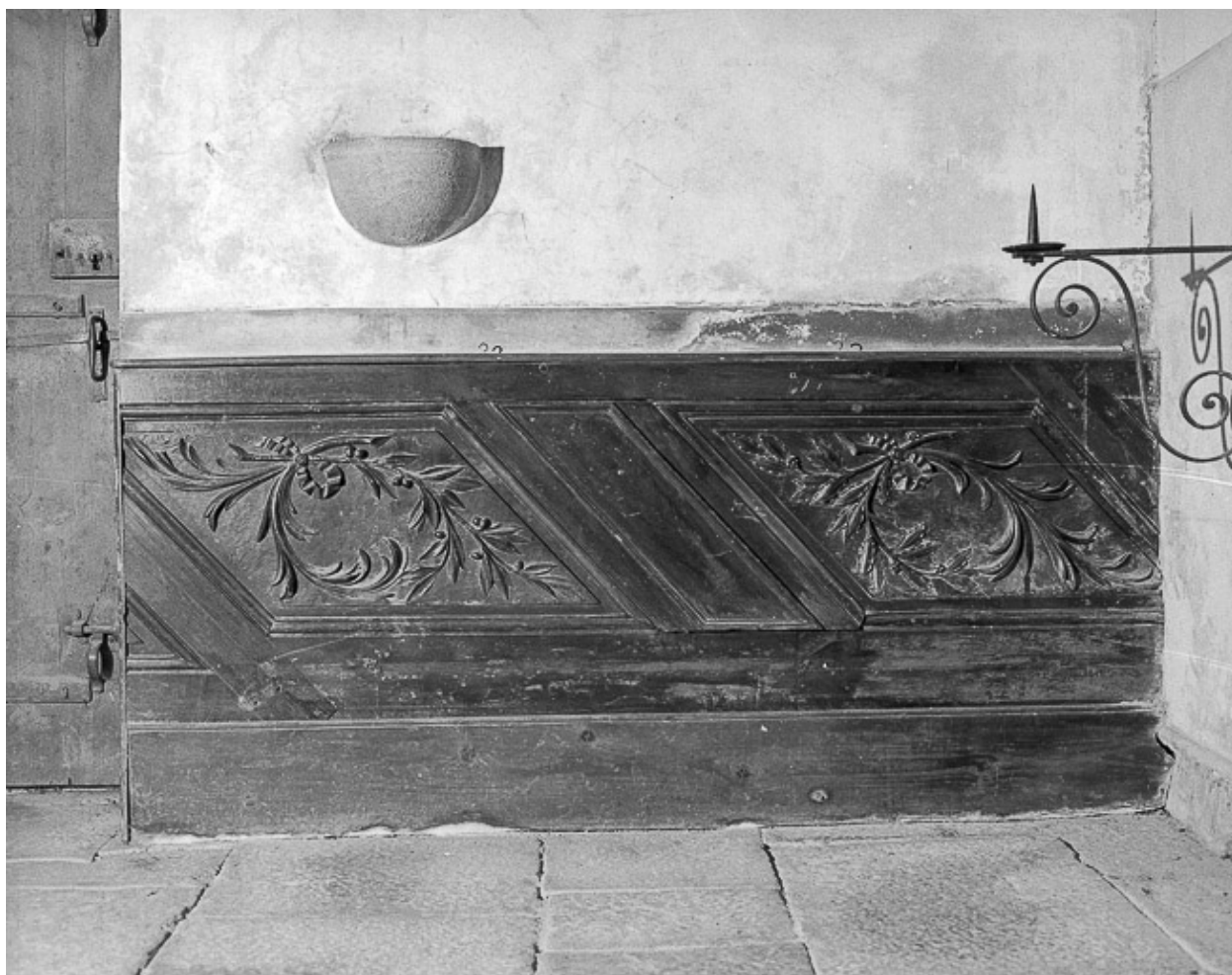
Détail : ancienne rampe utilisée en lambris.
