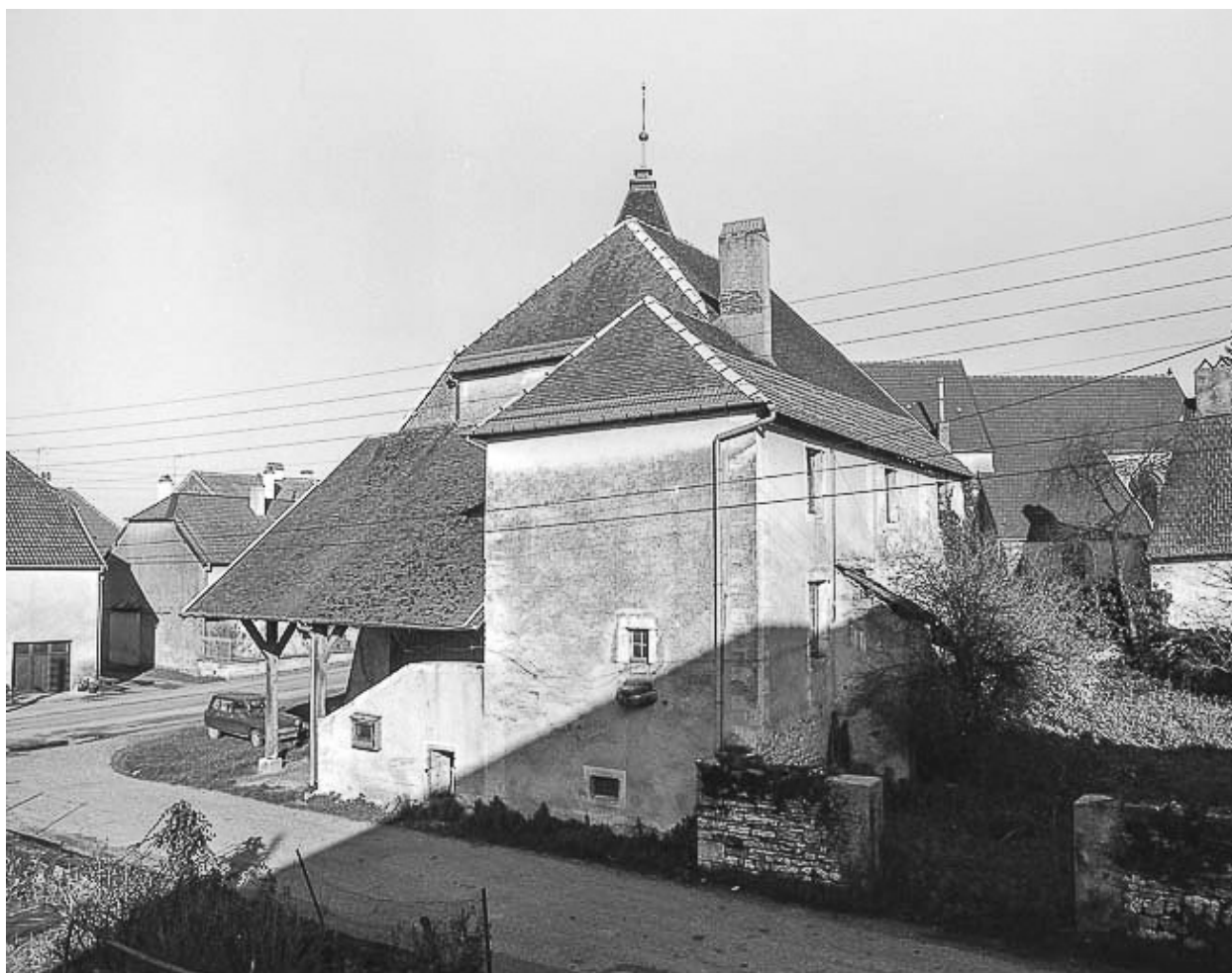
Façades postérieure et latérale droite en 1984.
