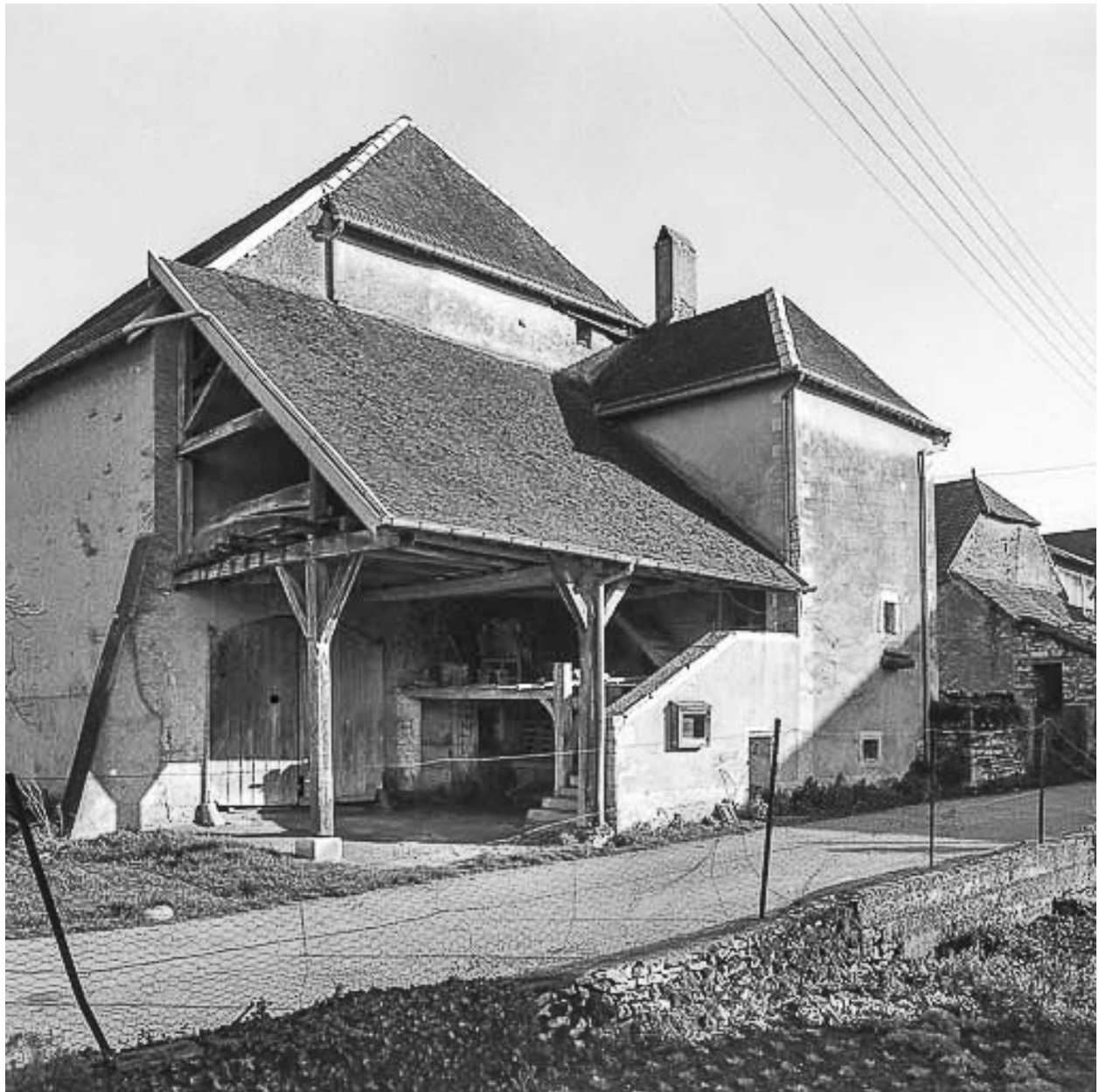
Détail : auvent et escalier extérieurs en 1984.
