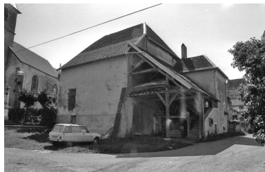
Vue d'ensemble depuis la Grande Rue en 1981. Phot. Bernard Lardière IVR43_19817000649Z
