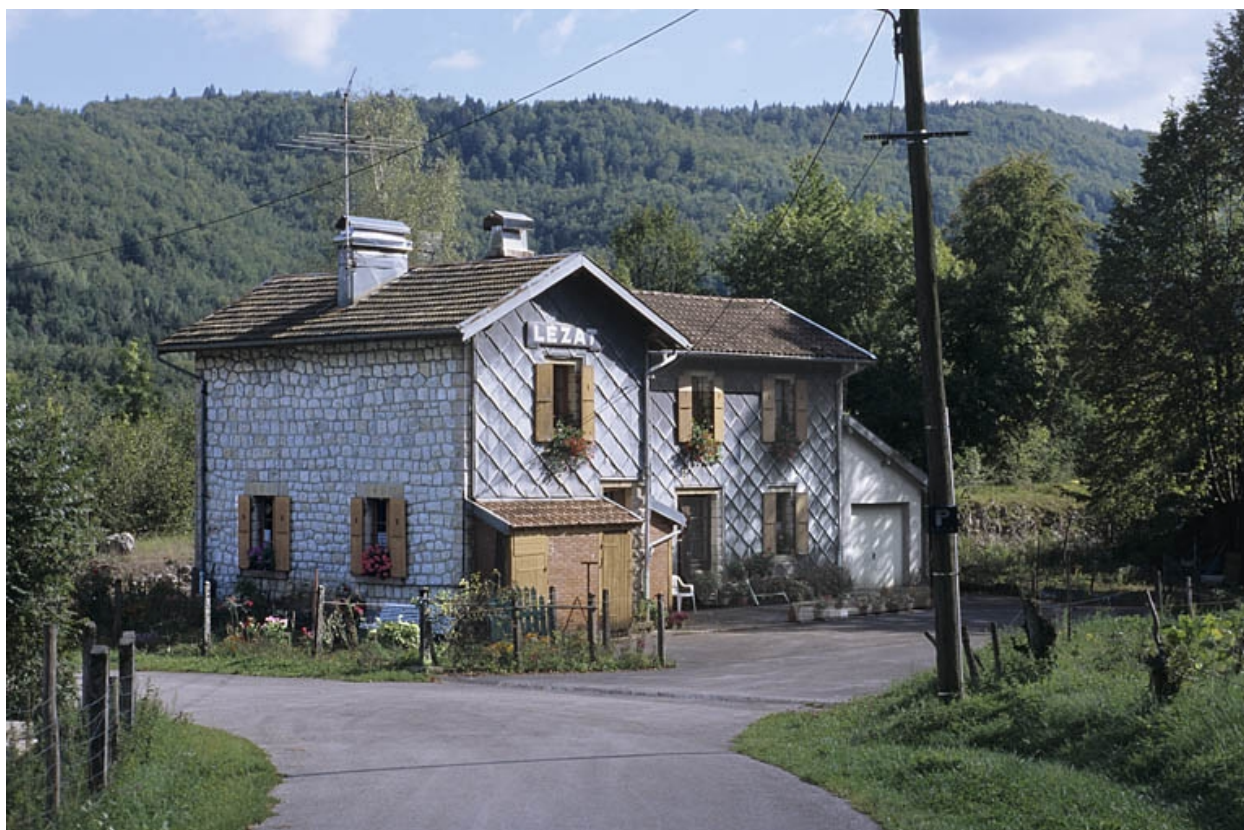
Façades antérieure et latérale gauche.
