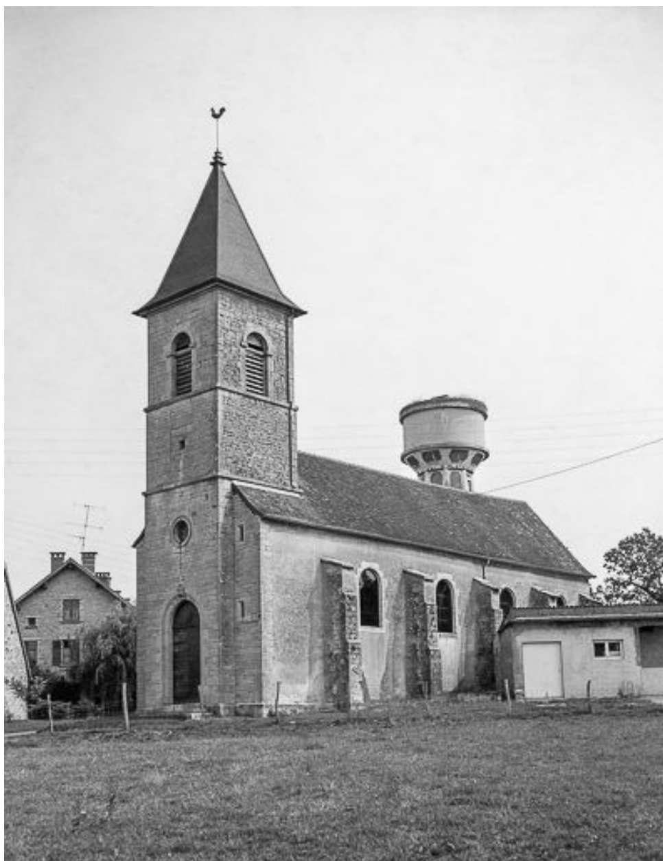
Façade antérieure et face droite.
