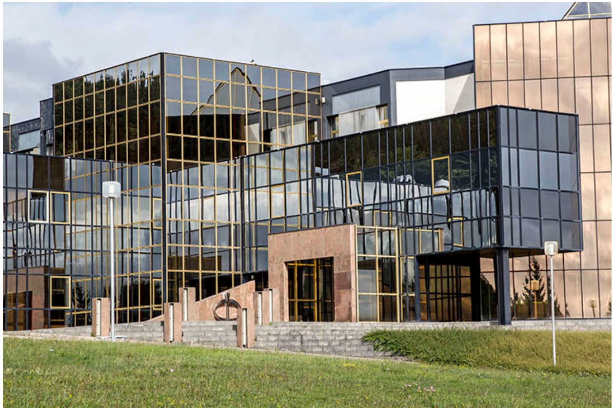
Usine de bijouterie et joaillerie Christian Bernard à Maîche.
