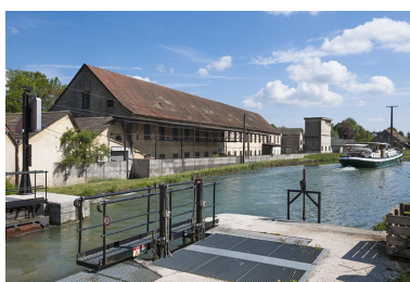
Ancienne usine textile Méquillet- Noblot à Colombier-Fontaine. Phot. Jérôme Mongreville IVR43_20132500442NUC4A
