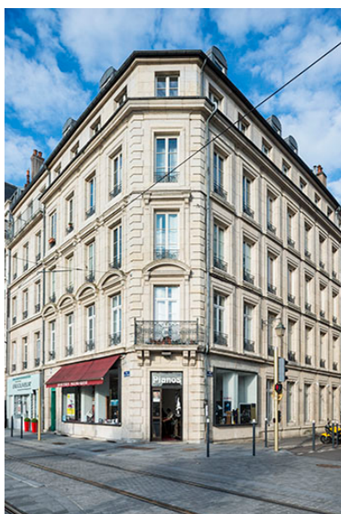
Immeuble et atelier d'horlogerie Sarda (33 quai Veil-Picard, Besançon). Phot. Jérôme Mongreville IVR43_20172501099NUC4A
