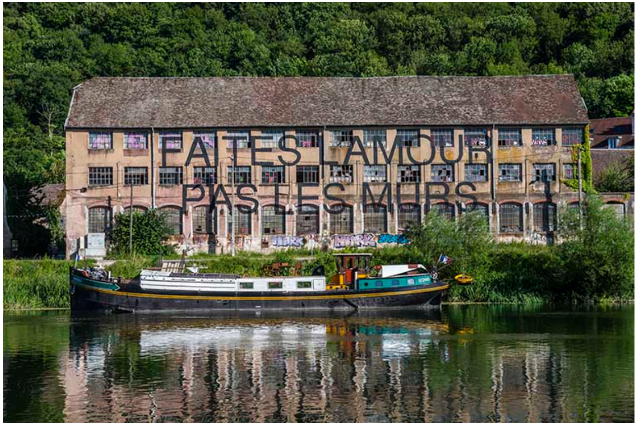
Usine de Casamène à Besançon : usine de construction mécanique, puis tissage et faïencerie.
