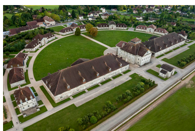
Saline d'Arc-et-Senans. Vue aérienne. Phot. Jérôme Mongreville IVR43_20152500430NUC4A
