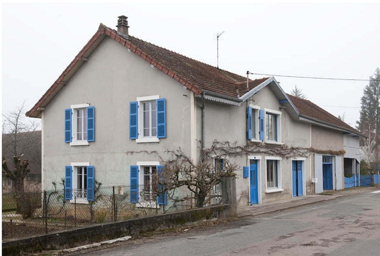
Façade antérieure et façade latérale gauche.
