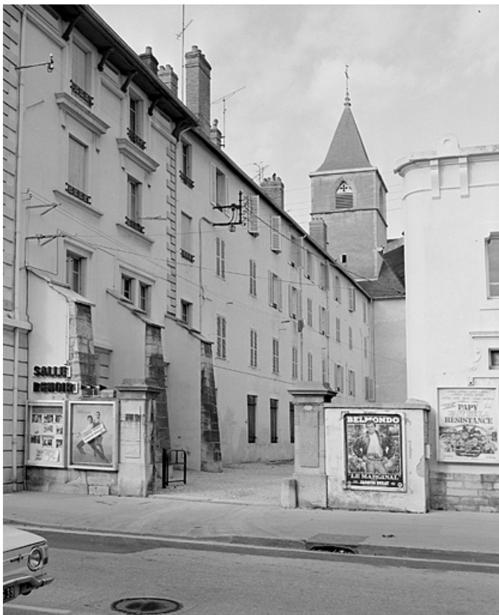
Anciens bâtiments conventuels. Façade latérale est.
