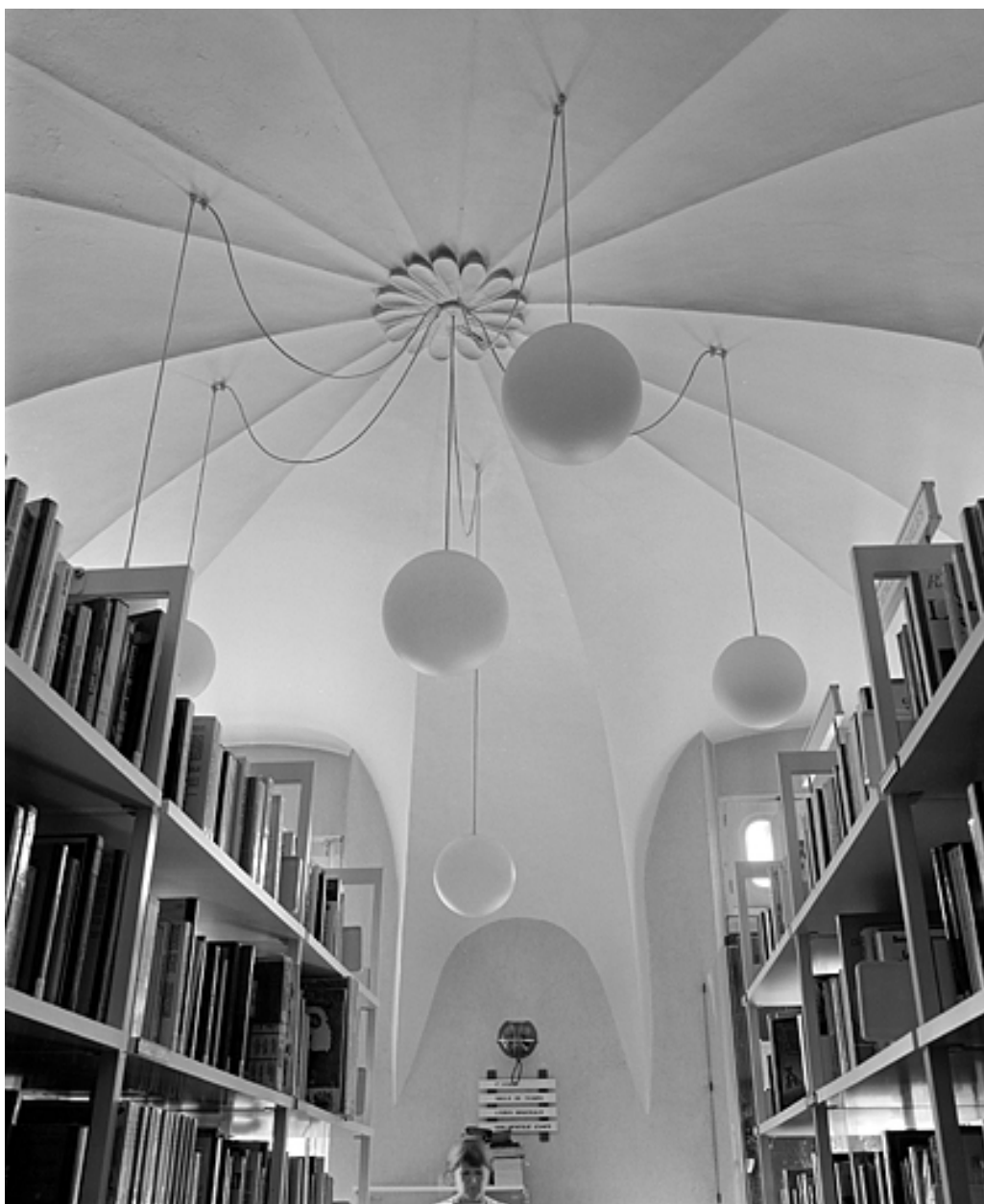
Bâtiments conventuels, voûte de l'ancienne cuisine.
