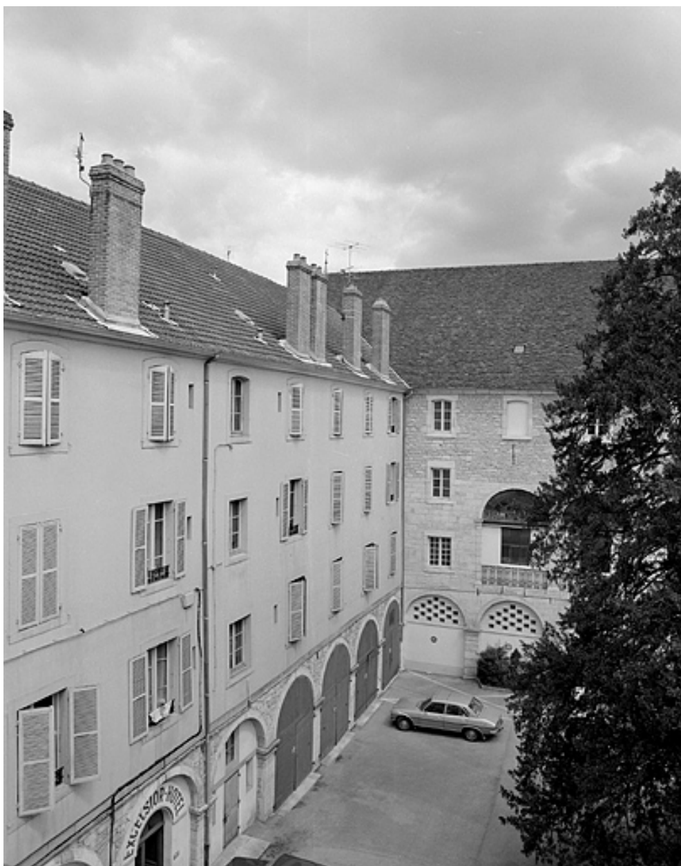
Bâtiments conventuels, cour intérieure, façade ouest.
