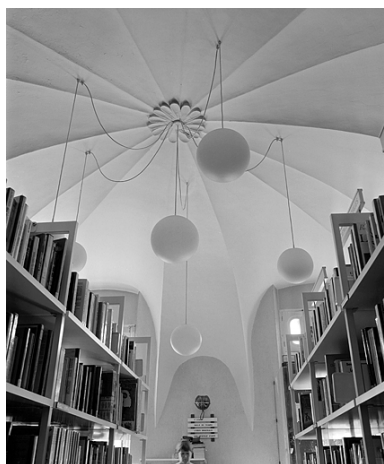
Bâtiments conventuels, voûte de l'ancienne cuisine.
