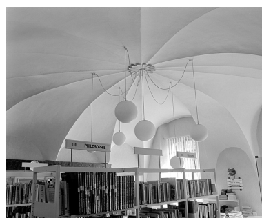
Bâtiments conventuels, voûte de l'ancienne cuisine. Phot. Yves Sancey IVR43_19853900296X
