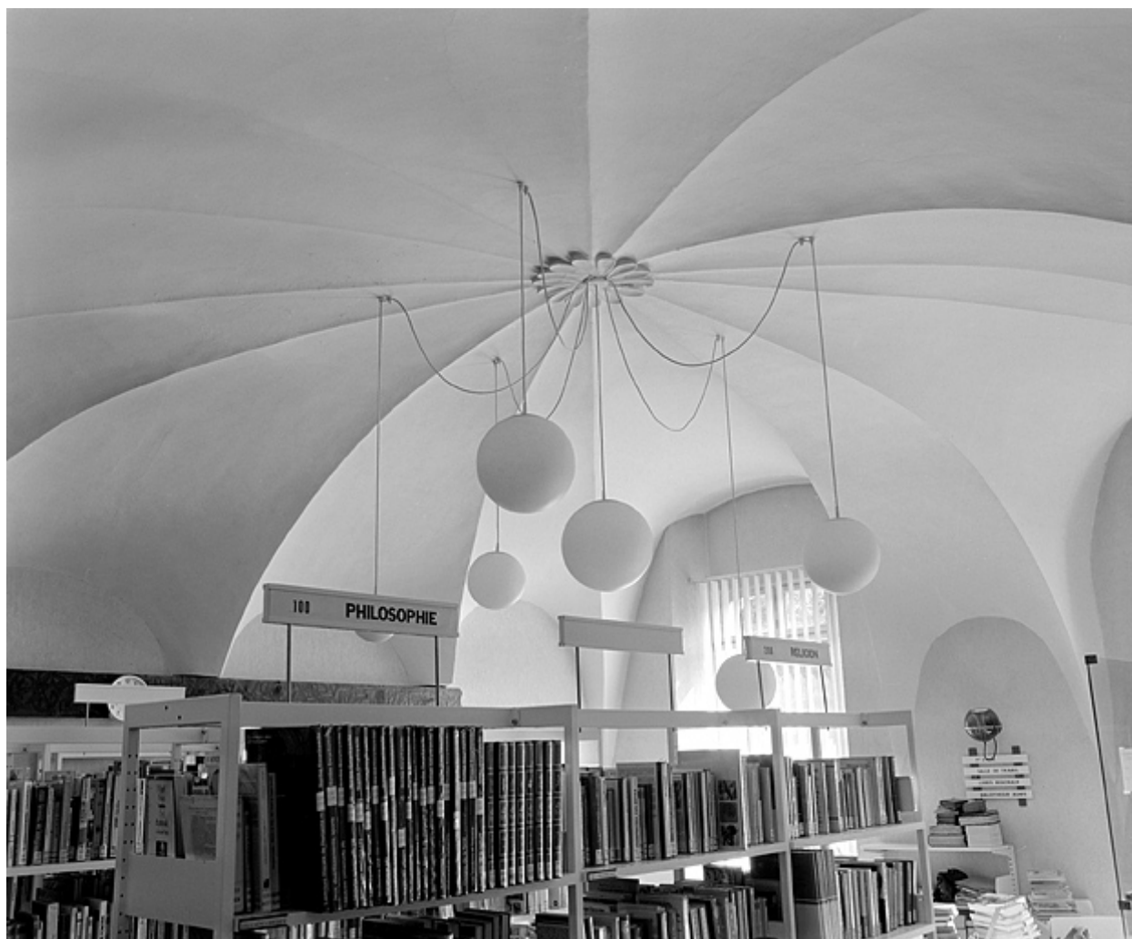
Bâtiments conventuels, voûte de l'ancienne cuisine.
