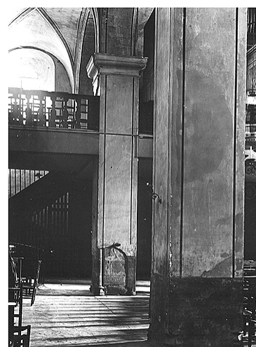
Eglise : vue du bas-côté montrant un pilier où l'on a partiellement enlevé le décor du 18e siècle, laissant voir l'état d'origine.
