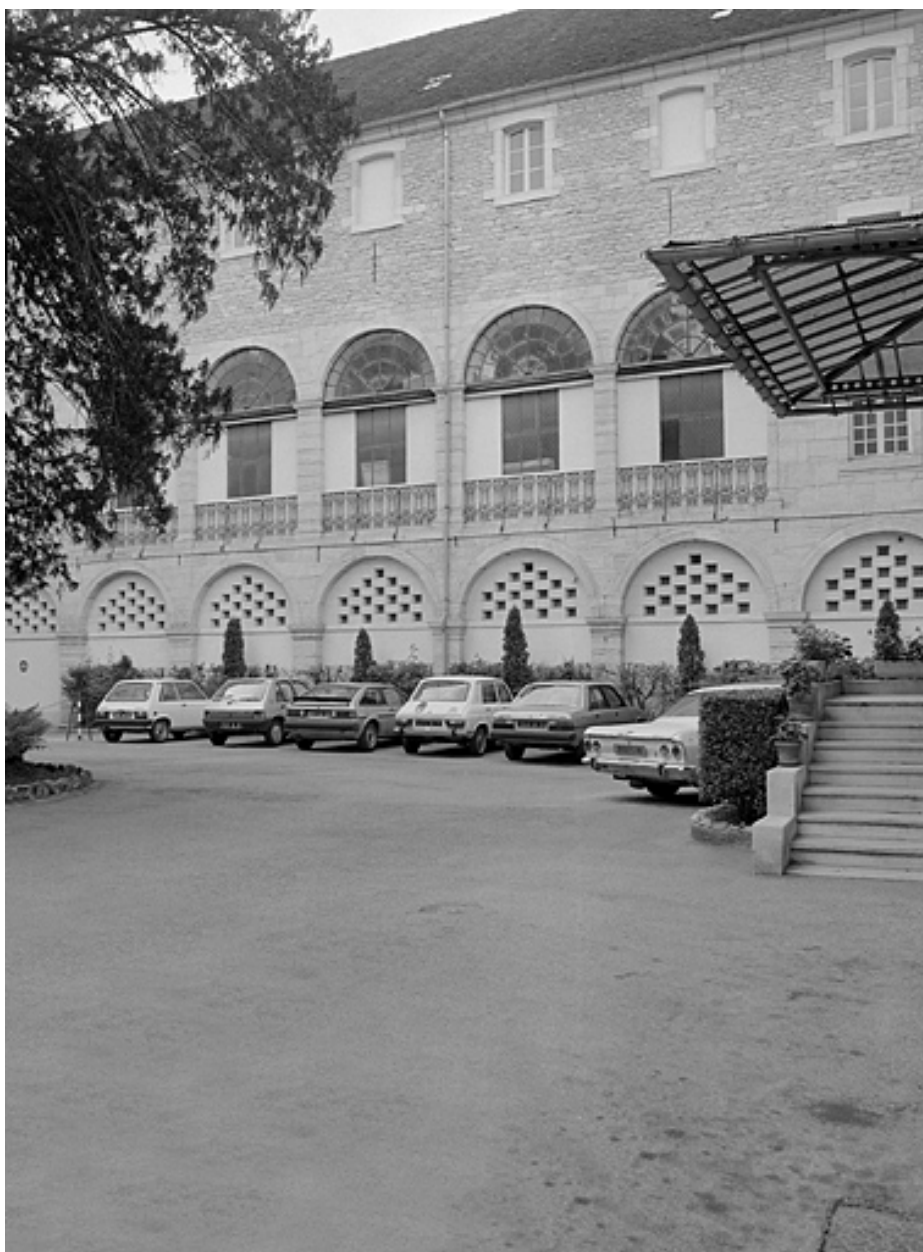
Bâtiments conventuels, cour intérieure, façade nord.
