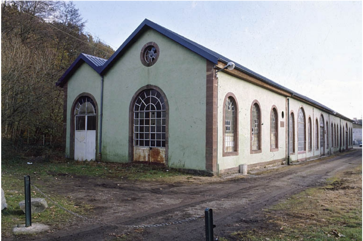
Salle des machines depuis le nord.
