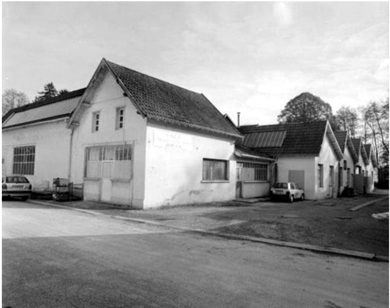
Ateliers de fabrication sud.
