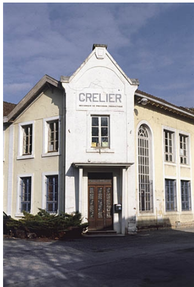
Bâtiment d'entrée : bureaux. Phot. Jérôme Mongreville IVR43_20019000591ZA
