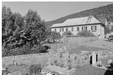
Vue de situation. Phot. Jérôme Mongreville IVR43_19973900740X
