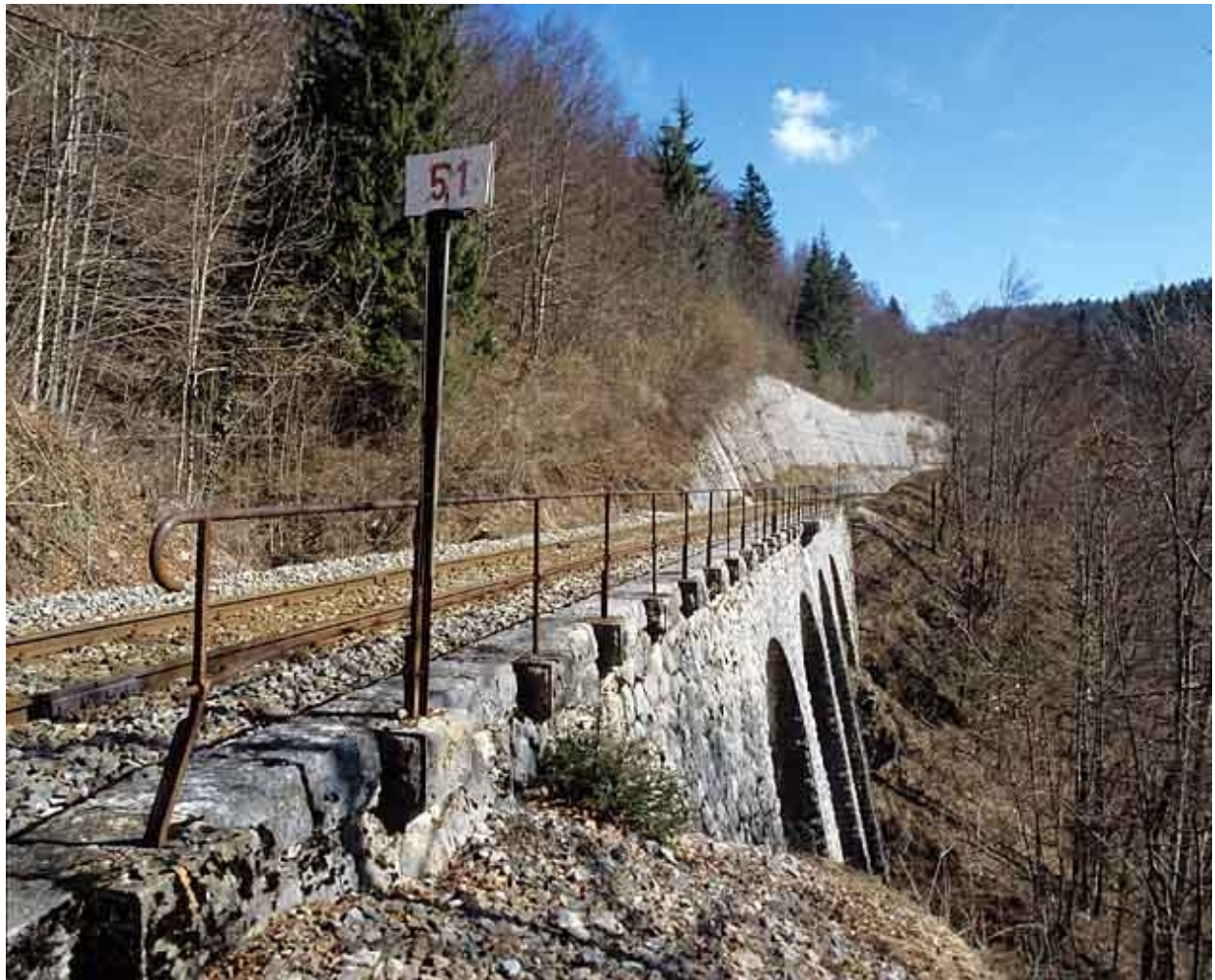
Vue d'ensemble en enfilade, depuis le sud-ouest.
