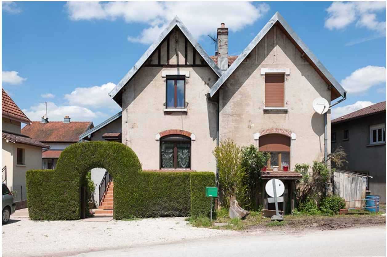
Façade antérieure d'une maison jumelée.
