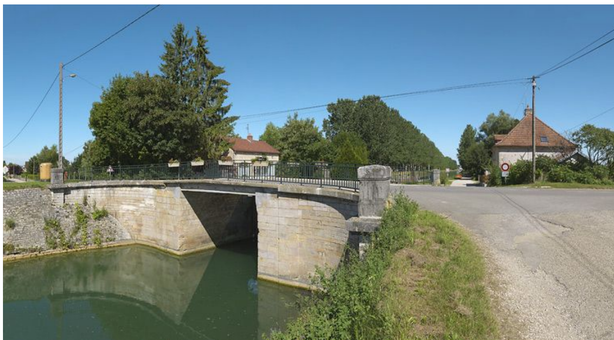
Vue d'ensemble prise d'aval.
