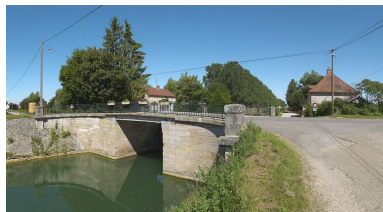
Vue d'ensemble prise d'aval. Phot. Thierry Kuntz IVR26_20112103173NUC4A
