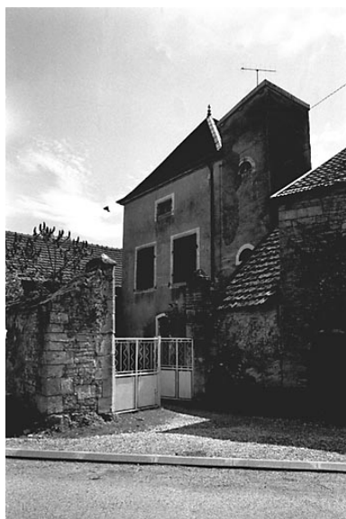
Vue d'ensemble. Phot. Bernard Lardière IVR43_19817000342Z
