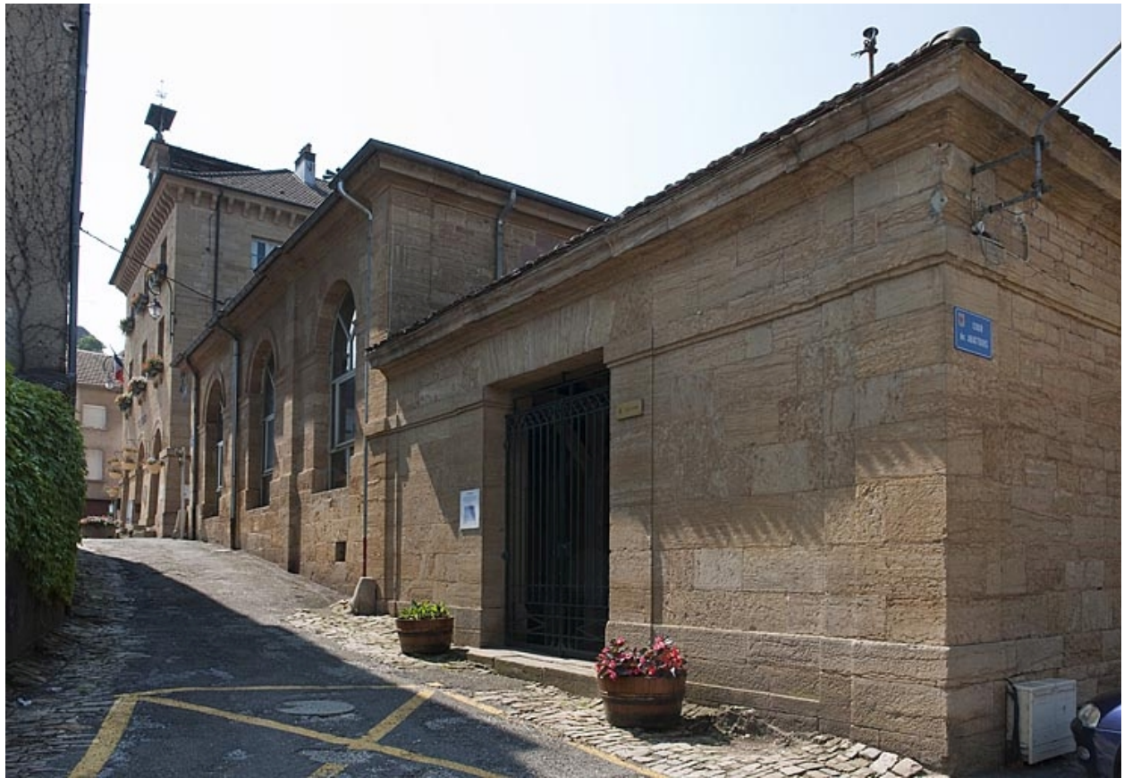
Façade rue du Lavoir.
