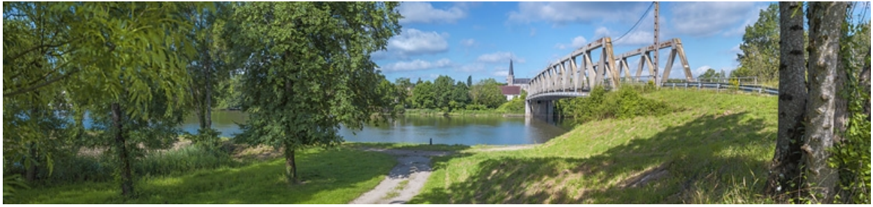
Vue d'ensemble, rive gauche.
