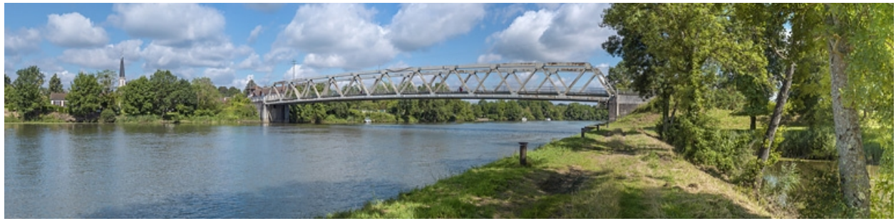
Vue d'ensemble, rive gauche.
