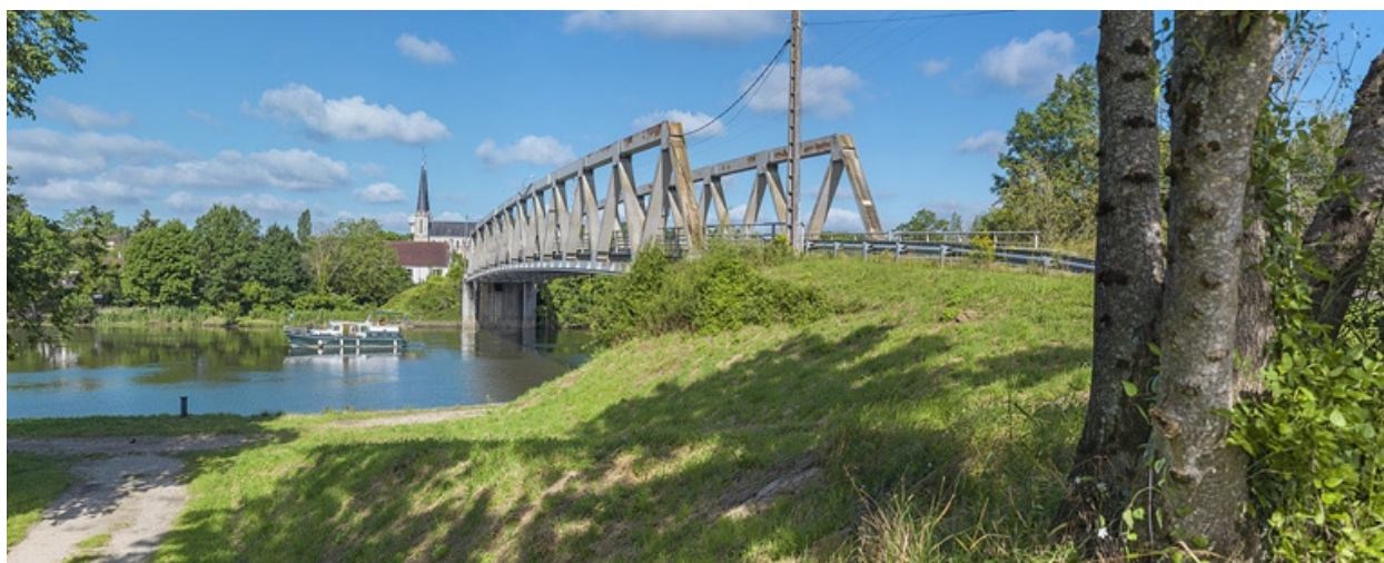
Vue d'ensemble, rive gauche.
