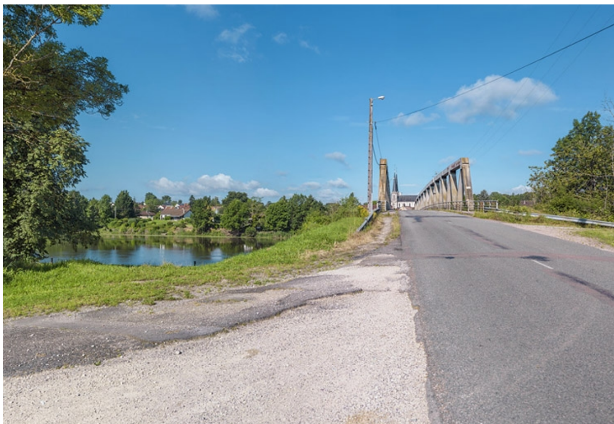
Vue d'ensemble, rive gauche.
