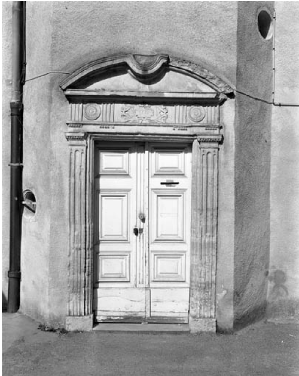
Détail de la porte d'entrée de l'escalier.
