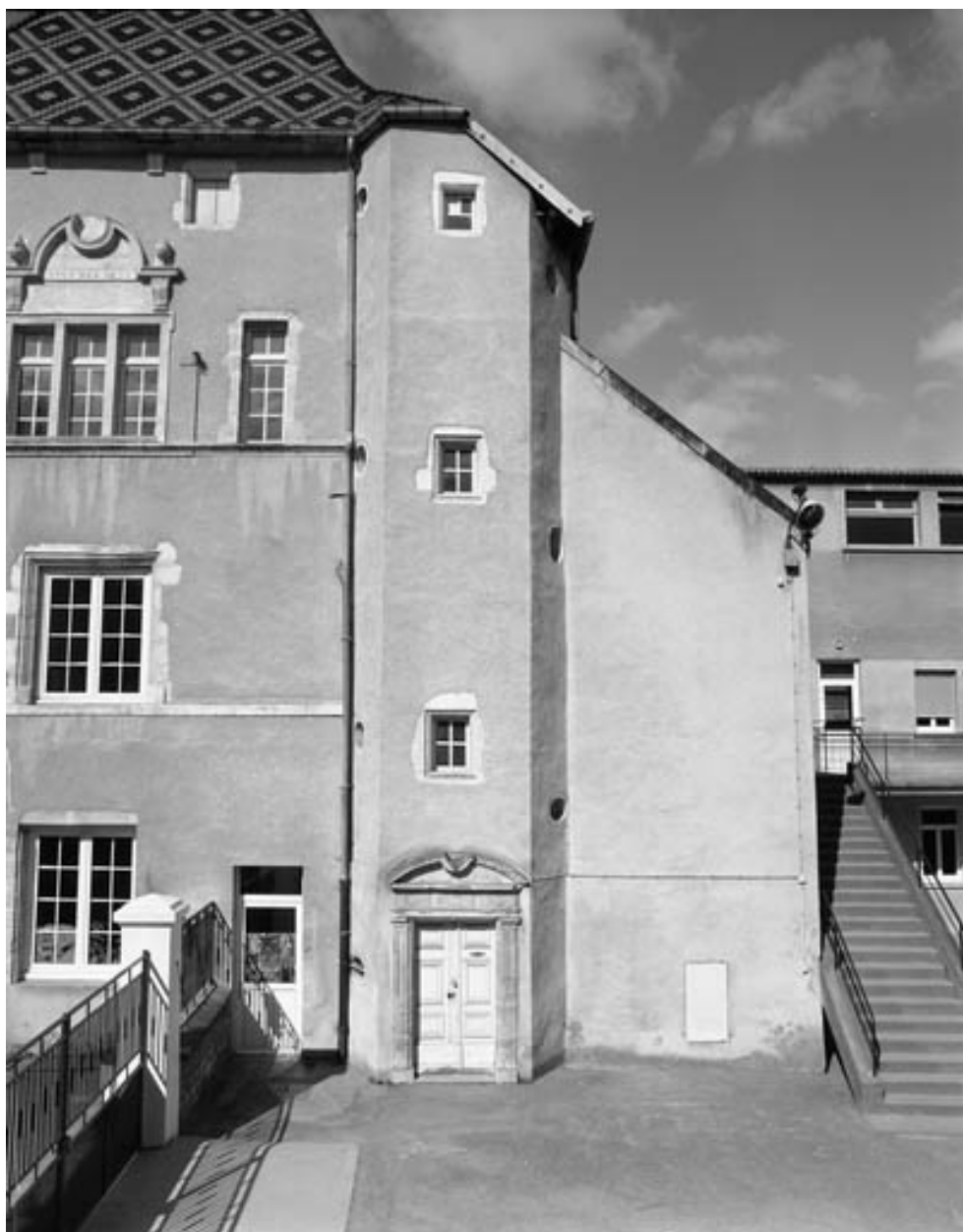
Détail de la tour d'escalier, de face.
