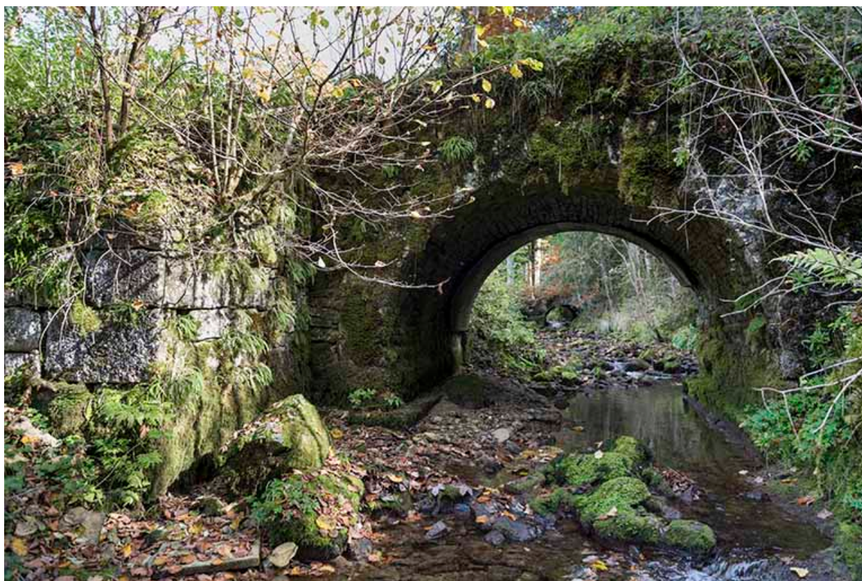
Pont en aval, à l'ouest.
