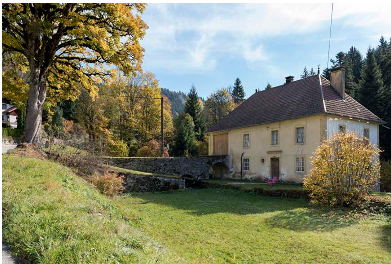
Vue d'ensemble rapprochée, depuis le nord-ouest.
