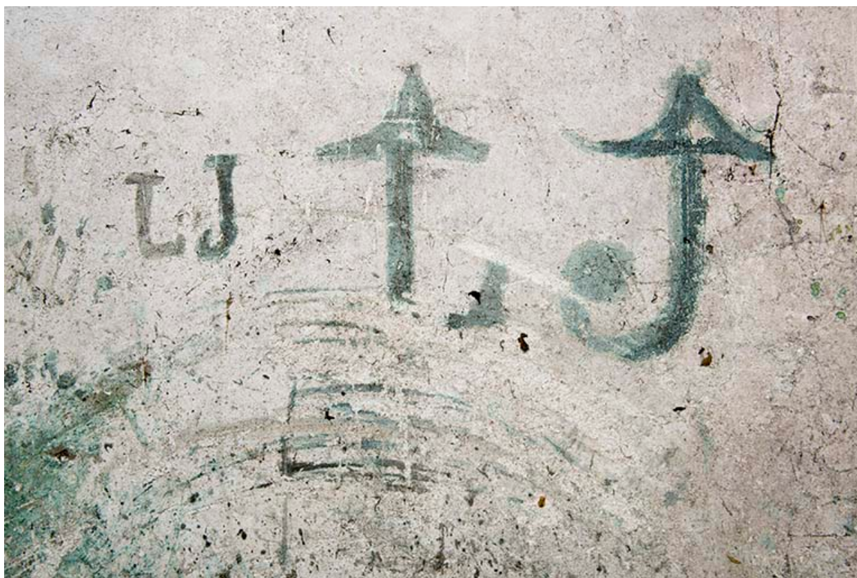
Initiales de Louis Jacquot (?) dans le couloir.
