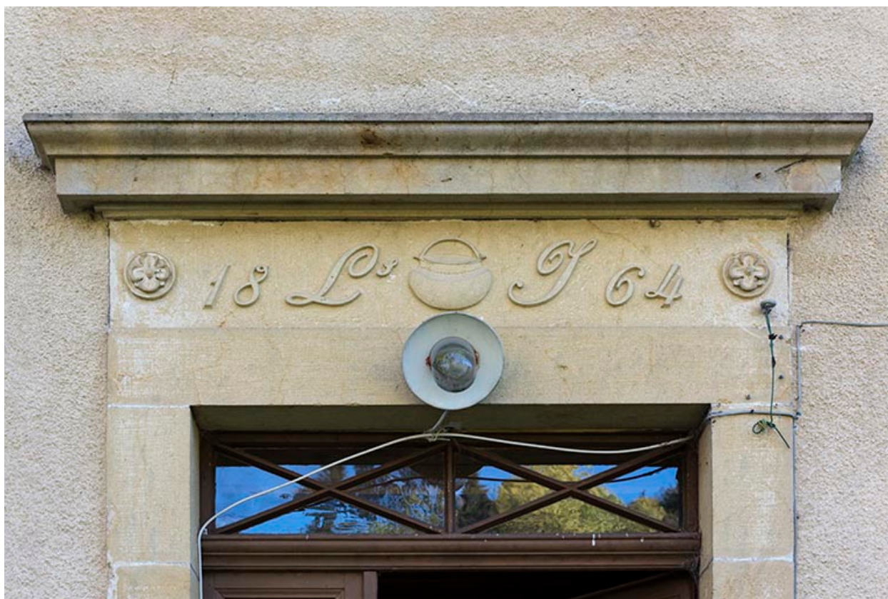
Façade antérieure : linteau sculpté et daté 1864.
