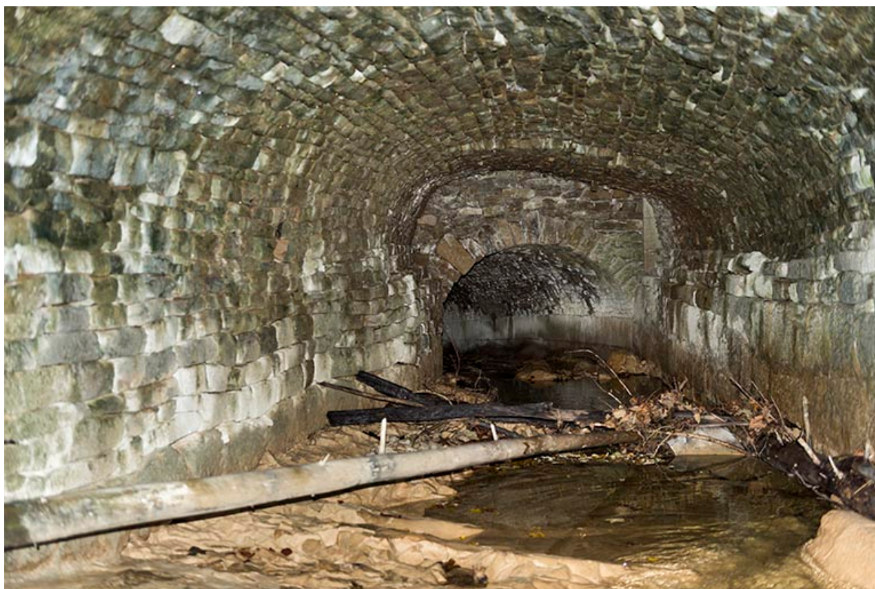
Voûte sur le ruisseau couvert.
