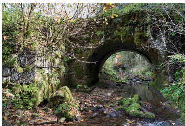
Pont en aval, à l'ouest.
