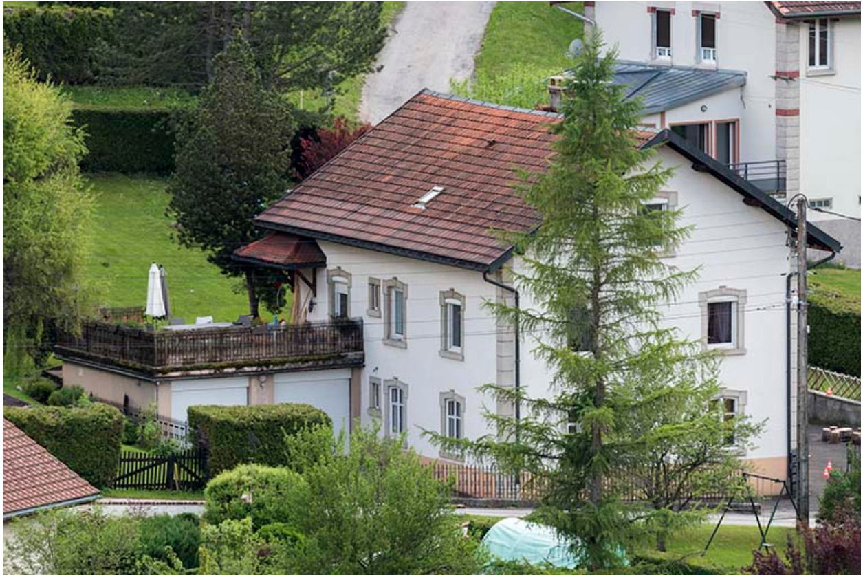
Façades postérieure et latérale gauche (vue plongeante).
