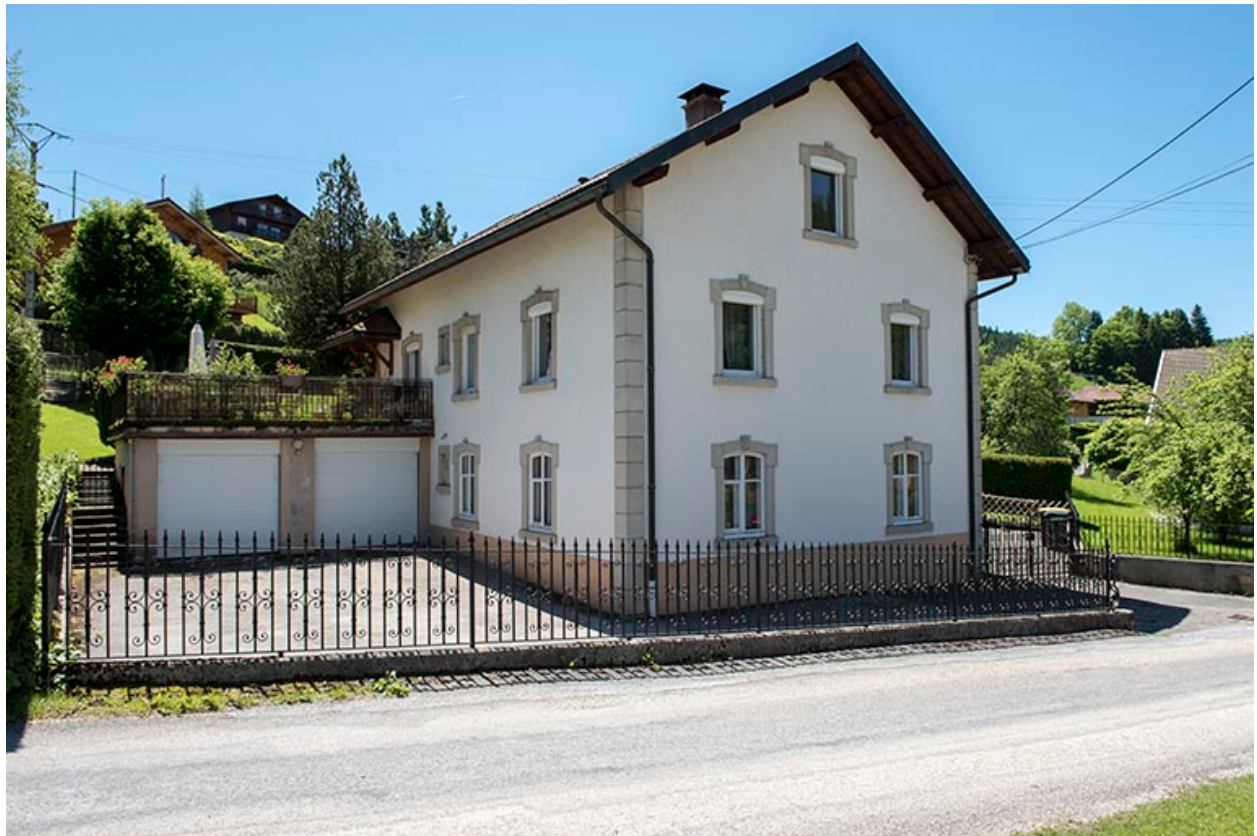
Façades postérieure et latérale gauche.
