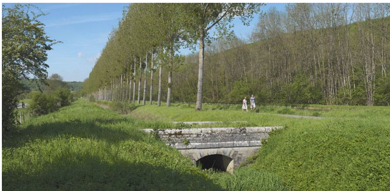
Pont sur rigole rive gauche.
