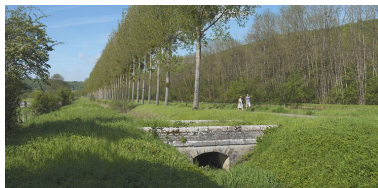
Pont sur rigole rive gauche. Phot. Thierry Kuntz IVR26_20122102476NUC4A
