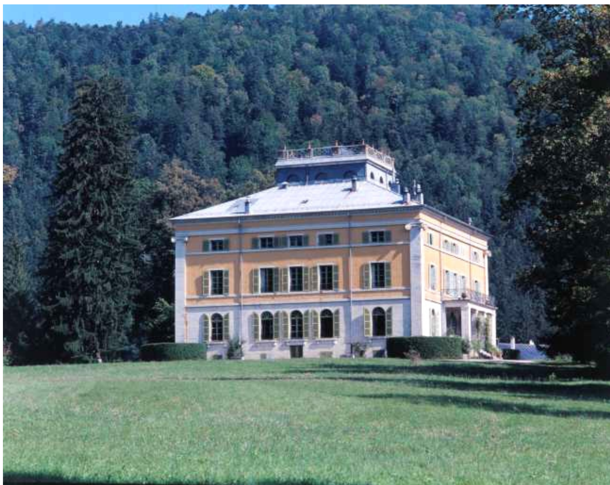
Vue des façades sud et ouest.
