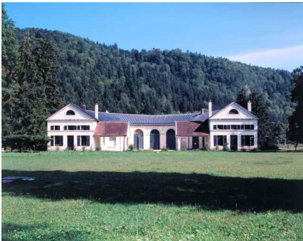
Vue d'ensemble de la ferme, de face.
