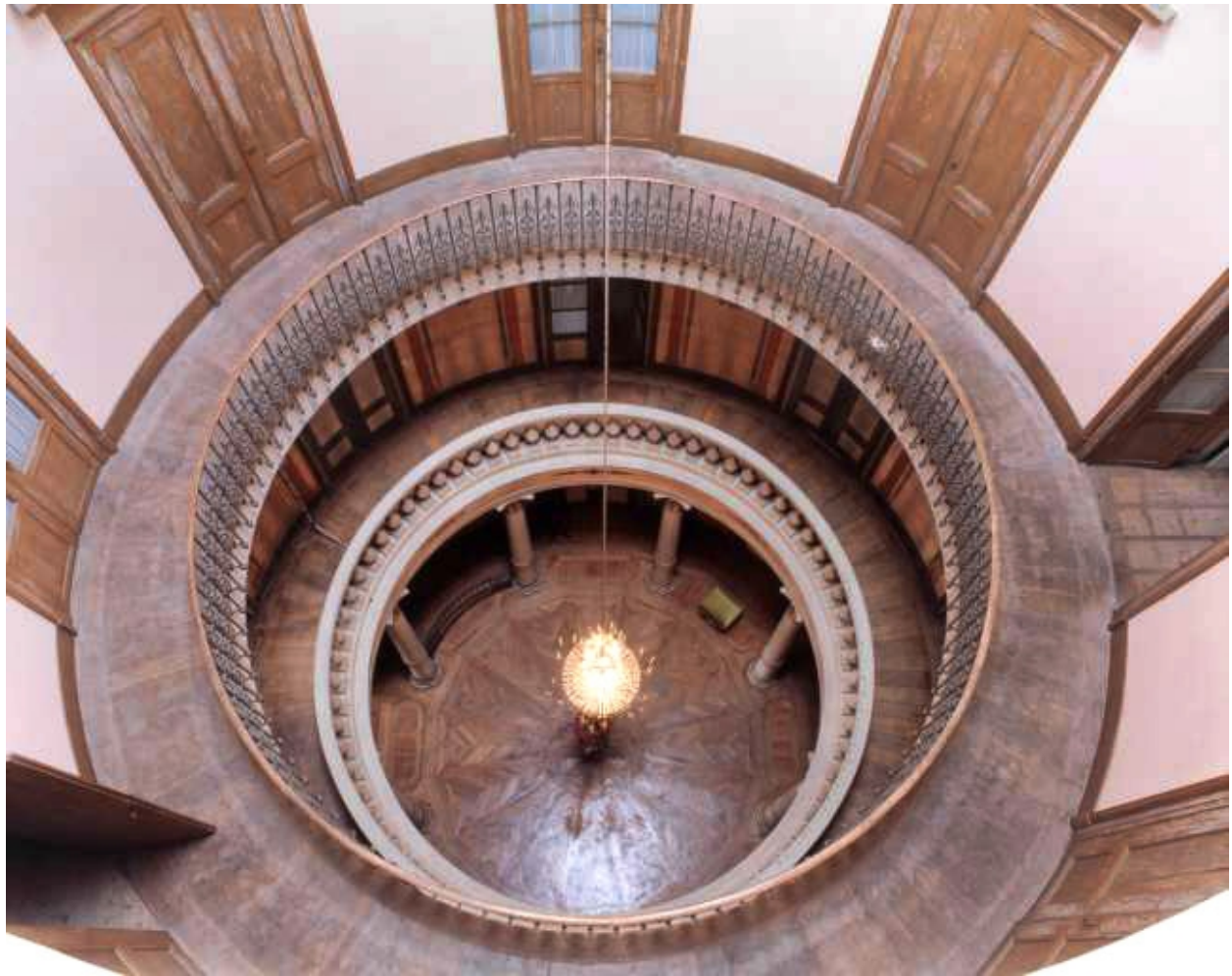
Intérieur : vue de la rotonde en plongée.
