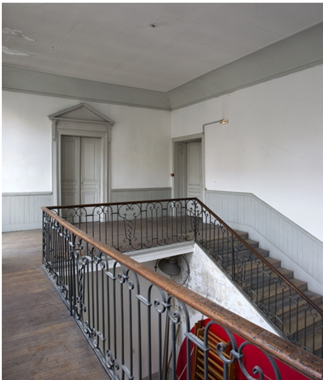
Logis principal, intérieur : vue d'ensemble de l'escalier.
