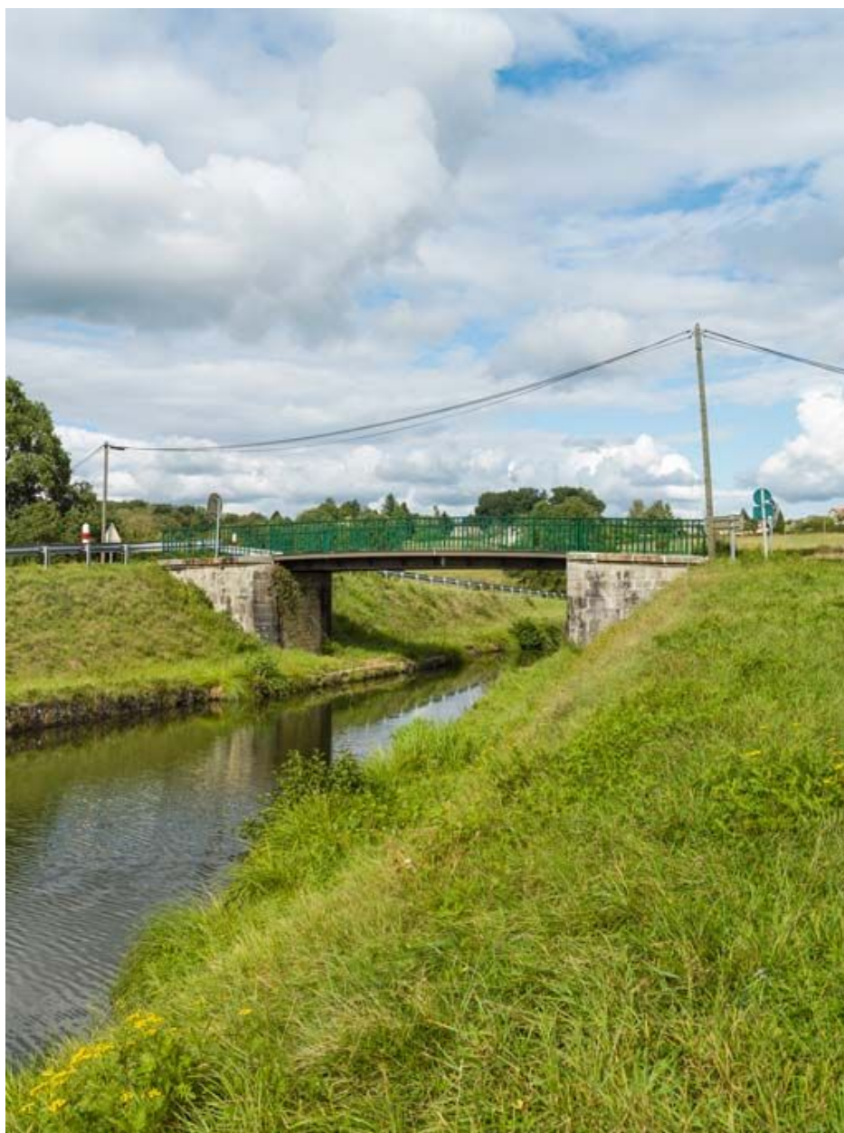
Vue d'ensemble du pont.
