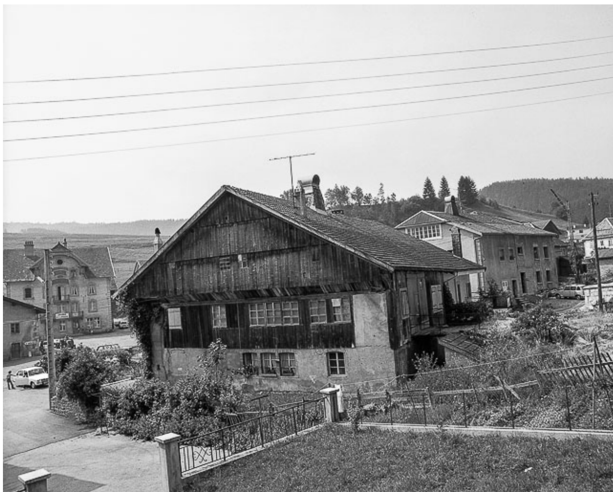
Façades postérieure et latérale droite, en 1976.
