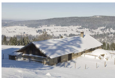
Vue d'ensemble, en hiver. Phot. Jérôme Mongreville IVR43_20082500949NUC2A
