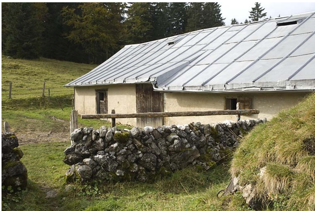
Muret de protection de la citerne.
