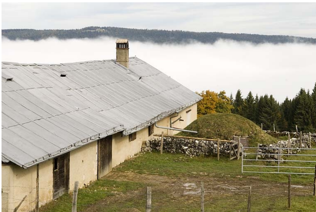
Façade antérieure vue en enfilade et citerne.
