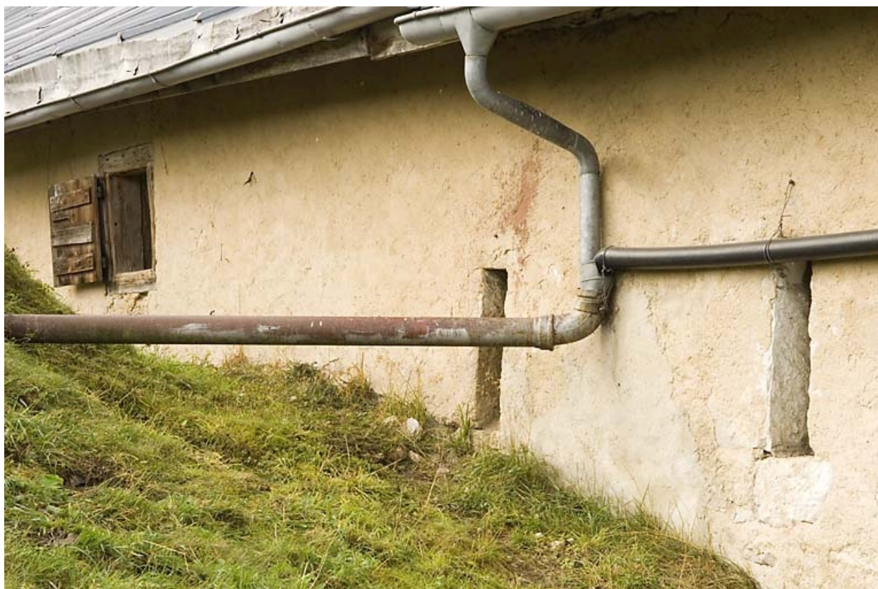
Façade antérieure : extrémité avec les baies fromagères.
