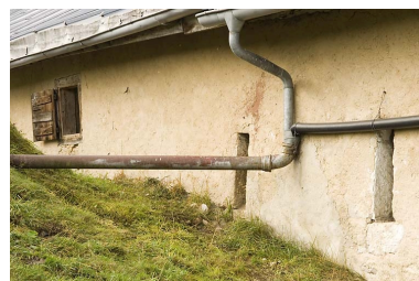
Façade antérieure : extrémité avec les baies fromagères. Phot. Jérôme Mongreville
