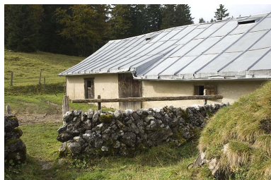
Muret de protection de la citerne. Phot. Jérôme Mongreville IVR43_20082500946NUC2A
