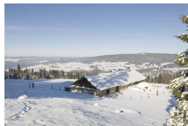
Vue d'ensemble depuis le nord, en hiver. Phot. Jérôme Mongreville IVR43_20082500950NUC2A
