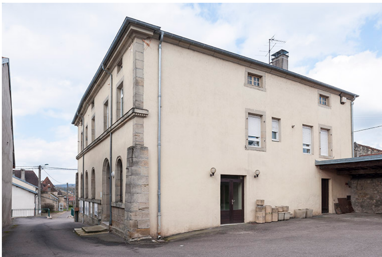
La façade postérieure.
