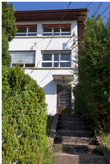
Usine : entrée sur la façade antérieure.
