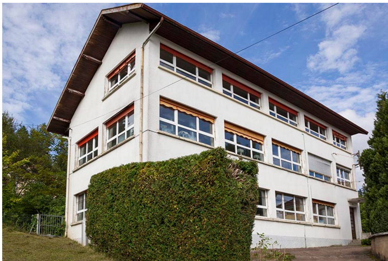
Usine : façades antérieure et latérale gauche.
