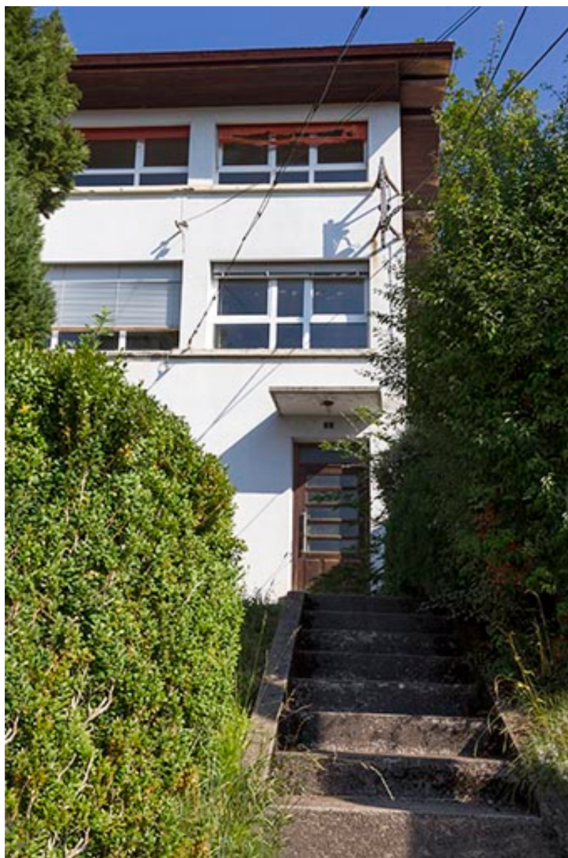
Usine : entrée sur la façade antérieure.
