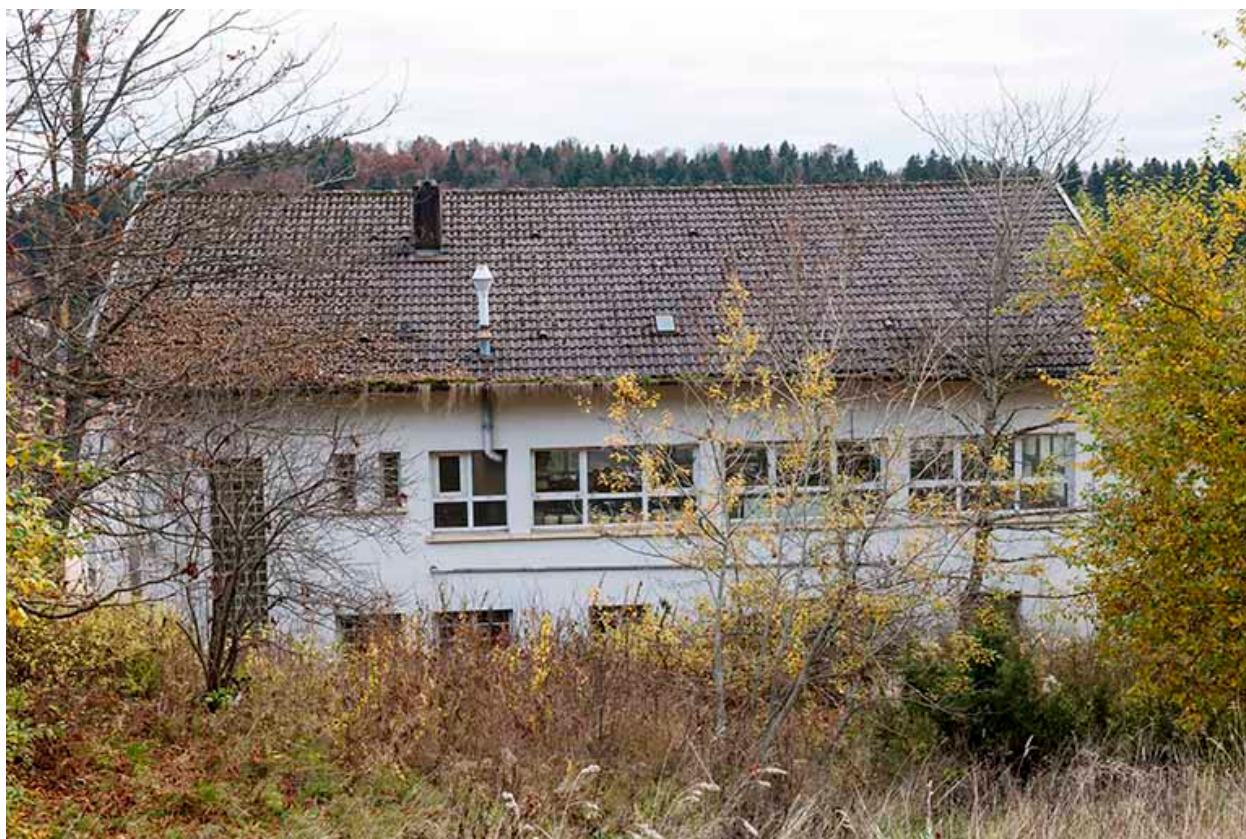
Usine : façade postérieure.
