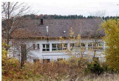
Usine : façade postérieure. Phot. Jérôme Mongreville IVR43_20152502165NUC4A
